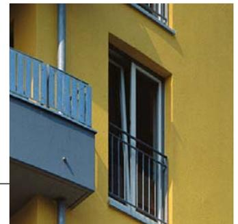
0,041  $W/(m \cdot K)$ , Dämmschichtdicke bis 200 mm. Schlussbeschichtung mit Mineral-Leichtputz oder keramischen Belägen.
