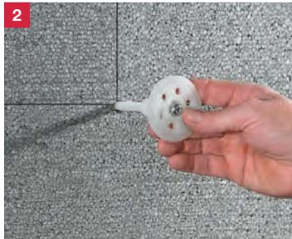
Dübel mit vormontierter Schraube in das Bohrloch stecken bis der Teller leicht aufliegt
