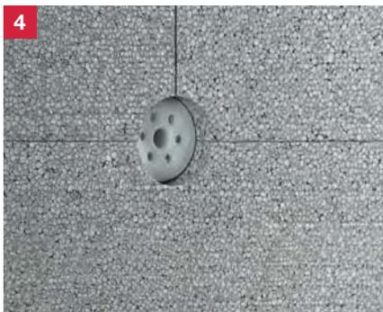
STR-Rondelle in die Vertiefung einsetzen ...
