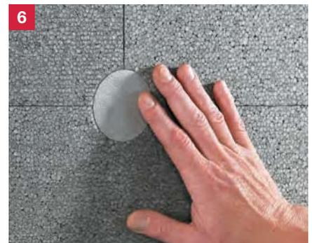
Fertig! Die homogene, glatte Oberfläche ermöglicht nun einen gleichmäßigen Putzauftrag
