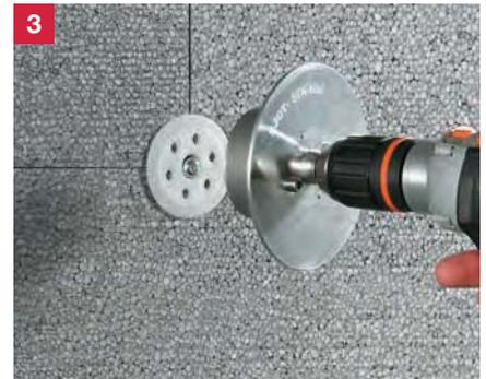
Einschrauben mit STR-Tool 2GS: Vertiefung wird automatisch erstellt
