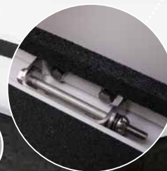
Einbruchhemmende Bänder aus Edelstahl
