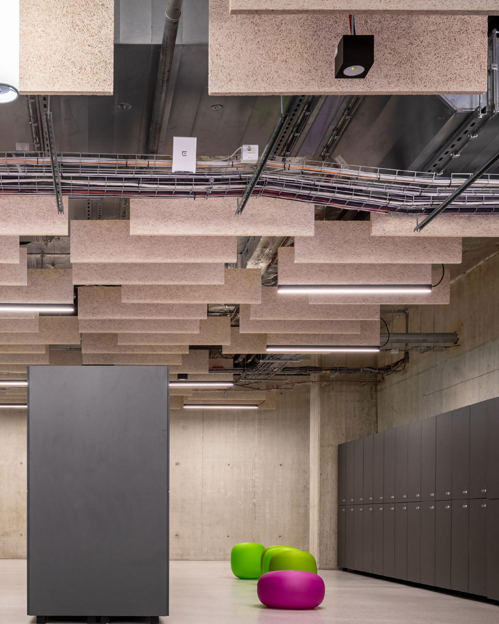
Projekt: Sportzentrum der Universitätsbibliothek Warschau, Polen Architekt: Architekci Studio Troldtekt-Lösung: Troldtekt-Baffeln (Montage als Kundenlösung) Foto: Piotr Skorek Photolicious
