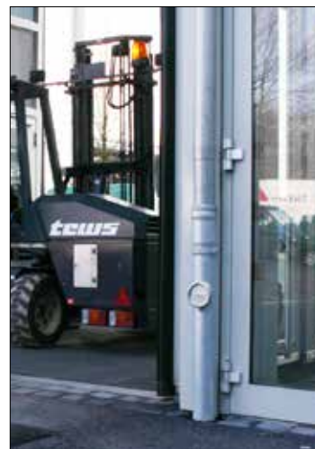
LORO-X Regenstandrohre in Bereichen, in denen mit mechanischer Beschädigung gerechnet werden muss.
