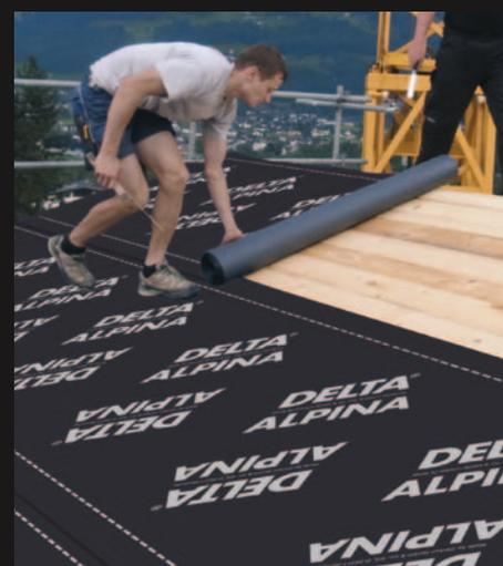
Wasser- und winddichte Unterdach- und Schalungsbahn
