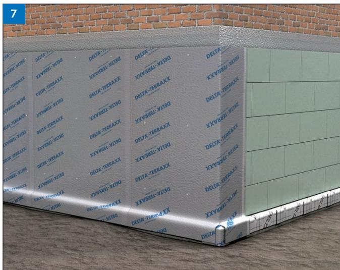
(Bild 7) Bei Außenecken die Bahn vor der Montage in der Kantenlinie einmal kräftig vorknicken.
