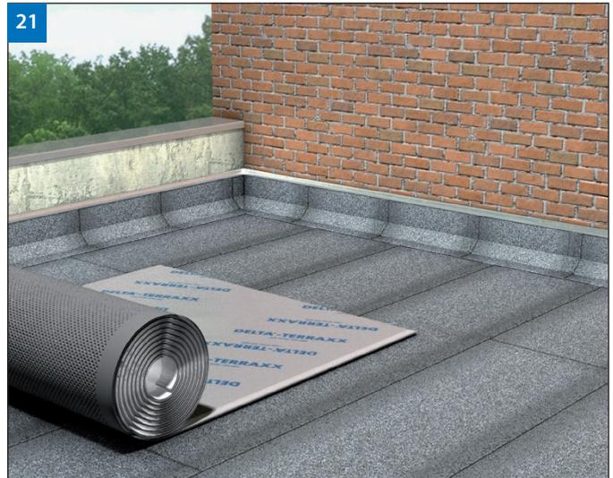
(Bild 21) Die Dränbahn wird einfach auf dem Untergrund bzw. der Abdichtung abgerollt. Dabei zeigt das filterstabile Geotextil immer nach oben zu den nachfolgenden Schichten. Mit einem Klagenmesser oder dem DELTA®-UNIVERSAL-MESSER wird die Bahn leicht auf die benötigte Länge zugeschnitten.
