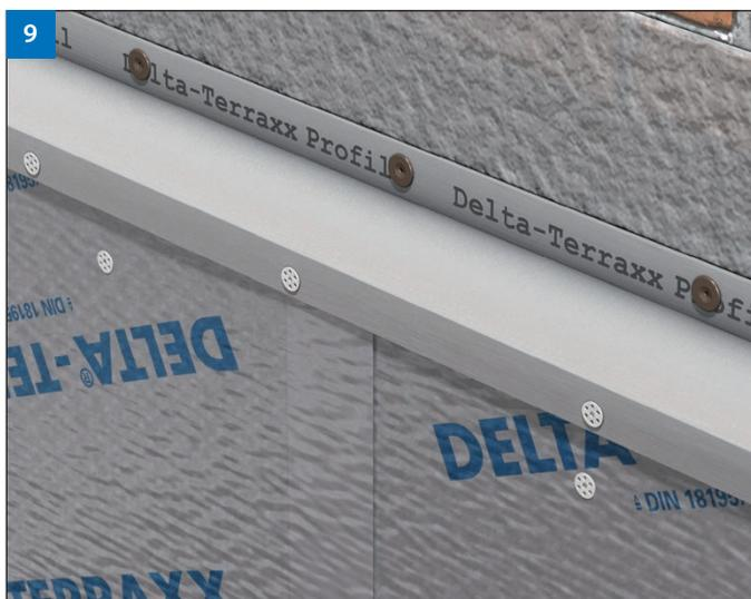
(Bild 9) Als oberen Abschluss beim Einsatz auf Perimeterdämmplatten das DELTA®-TERRAXX-PROFIL befestigen.
