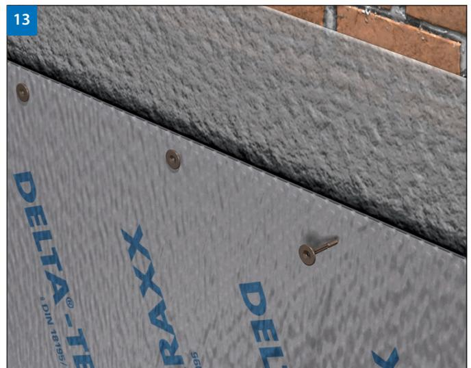
(Bild 13) Steht die endgültige Geländehöhe fest, kann die Bahn auch direkt mit dem DELTA®-MS Dübel befestigt werden.
