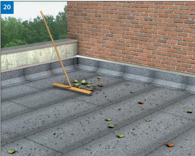
(Bild 20) Der abgedichtete Untergrund muss gründlich gereinigt werden, damit nach der Verlegung der Dränbahn keine Beschädigungen an der Abdichtung entstehen können. Im Fall einer Dachbegrünung muss diese Abdichtung wurzelfest sein oder durch eine zusätzliche Wurzelschutzfolie geschützt werden.
