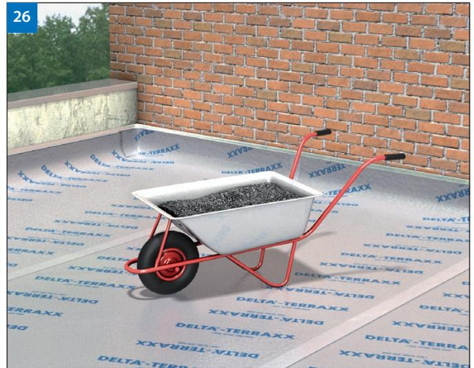
(Bild 26) Beim Einsatz unter erdüberschütteten Decken kann die verlegte Dränbahn auch problemlos direkt mit einer Schubkarre befahren werden. Wenn die Bodenausschüttung vorausläuft, kann DELTA®-TERRAXX in der Bauphase auch mit Radladern befahren werden; deren Einsatz ist auf einer Ausschüttung von mindestens 20 cm möglich.
