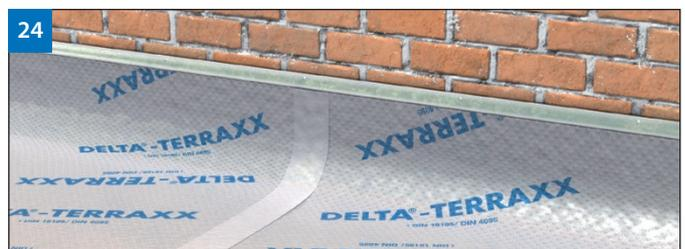
(Bild 23 und 24) Auf eine ausreichende Überlappung der Bahnen ist zu achten (im Bereich der Kopfstöße ca. 10 – 20 cm). An den Längsseiten der Bahn wird zur Überlappung die Anschlussbahn unter das angehoebene Vlies geschoben. Anschließend einfach den Abdeckstreifen des Klebebandes abziehen und beide Noppenbahnen miteinander verkleben.
