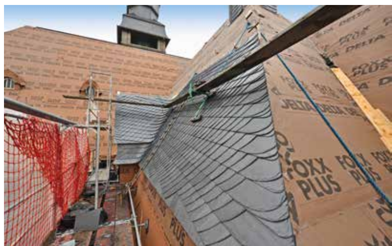
DELTA®-FOXX PLUS als diffusionsoffene Vordeckung.
