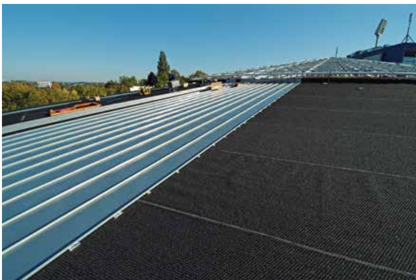
DELTA®-TRELA PLUS als Trennlage bei Metalldeckung.
