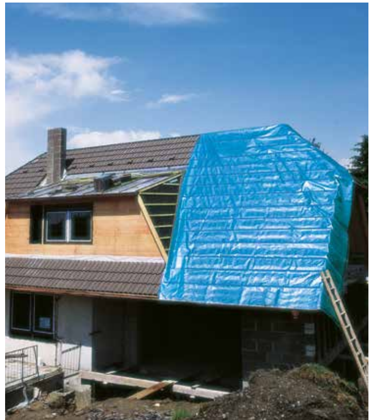
DELTA®-DACHPLANE als regensichere Behelfsdeckung.
