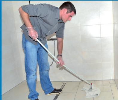
Die Oberfläche trocknen. Es darf kein stehendes Wasser auf der Fläche/Fuge vorhanden sein. Die Fuge darf aber feucht sein.
