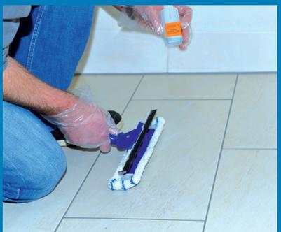
...und mit der Kante des Werkzeuges zügig und gleichmäßig zu einem satten Feuchtfilm verteilen. Die Einwirkzeit auf Fliesen liegt zwischen 10 und 30 Minuten.
