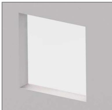
Bauöffnungsmaß anzeichnen und herstellen bzw. beim Wandaufbau berücksichtigen. Bauöffnungsmaß Massivbau = Nennmaße +10mm.
