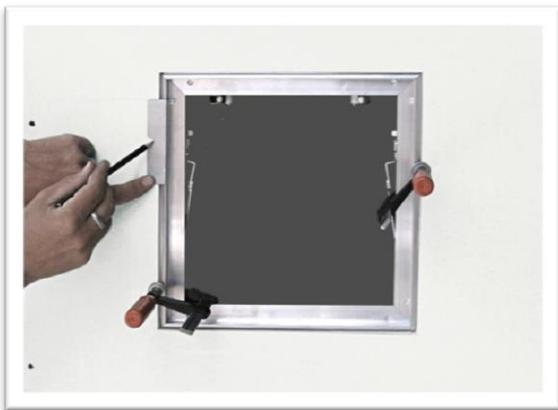
3. Rahmen ausrichten (Winkligkeit prüfen), festspannen und Bohrungen mit Schablone anzeichnen, Bohrabstand <math>< 100\text{ mm}</math>
