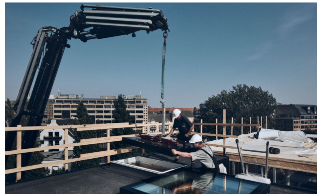
Der Glasaufsatz wird montiert
