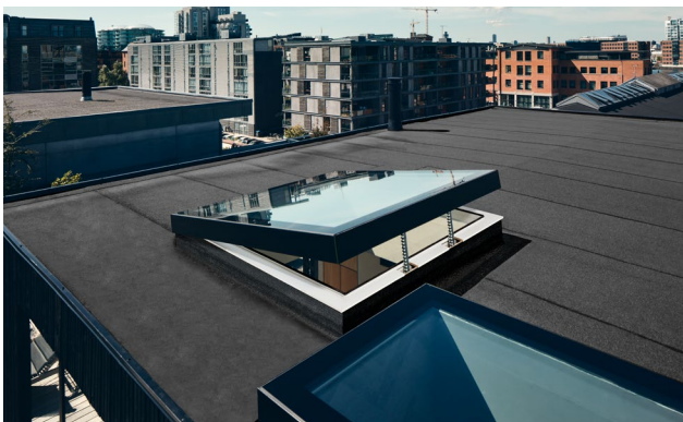
Die elektrischen Anschlüsse herstellen und auf ihre Funktionalität prüfen
