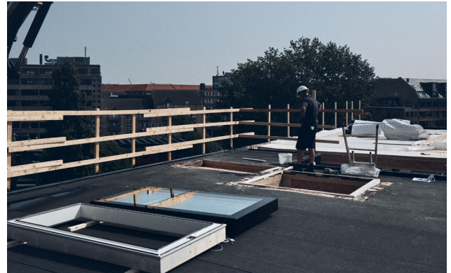
Die Dachöffnung wird für den Aufsetzkranz vorbereitet
