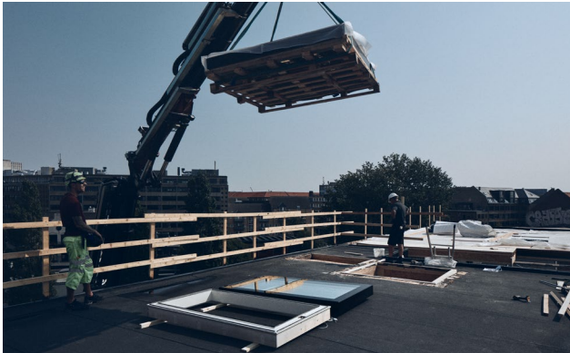
Die Elemente werden auf das Dach befördert
