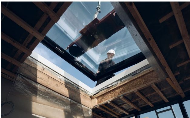
Der Glasaufsatz wird montiert
