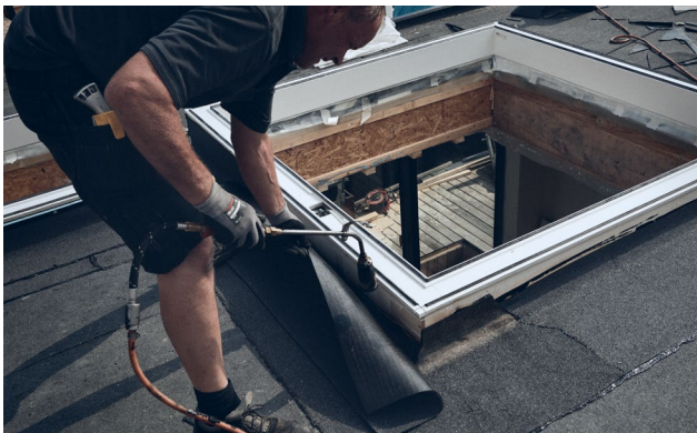
Sicherstellen, dass der Aufsetzkranz und das Dachmaterial wasserfest sind, ohne das Produkt den Flammen auszusetzen
