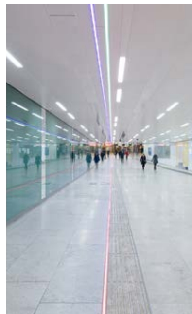
Brandschutzverglasung EI30/EI60 – Karlsplatzpassage, Wien, Österreich
