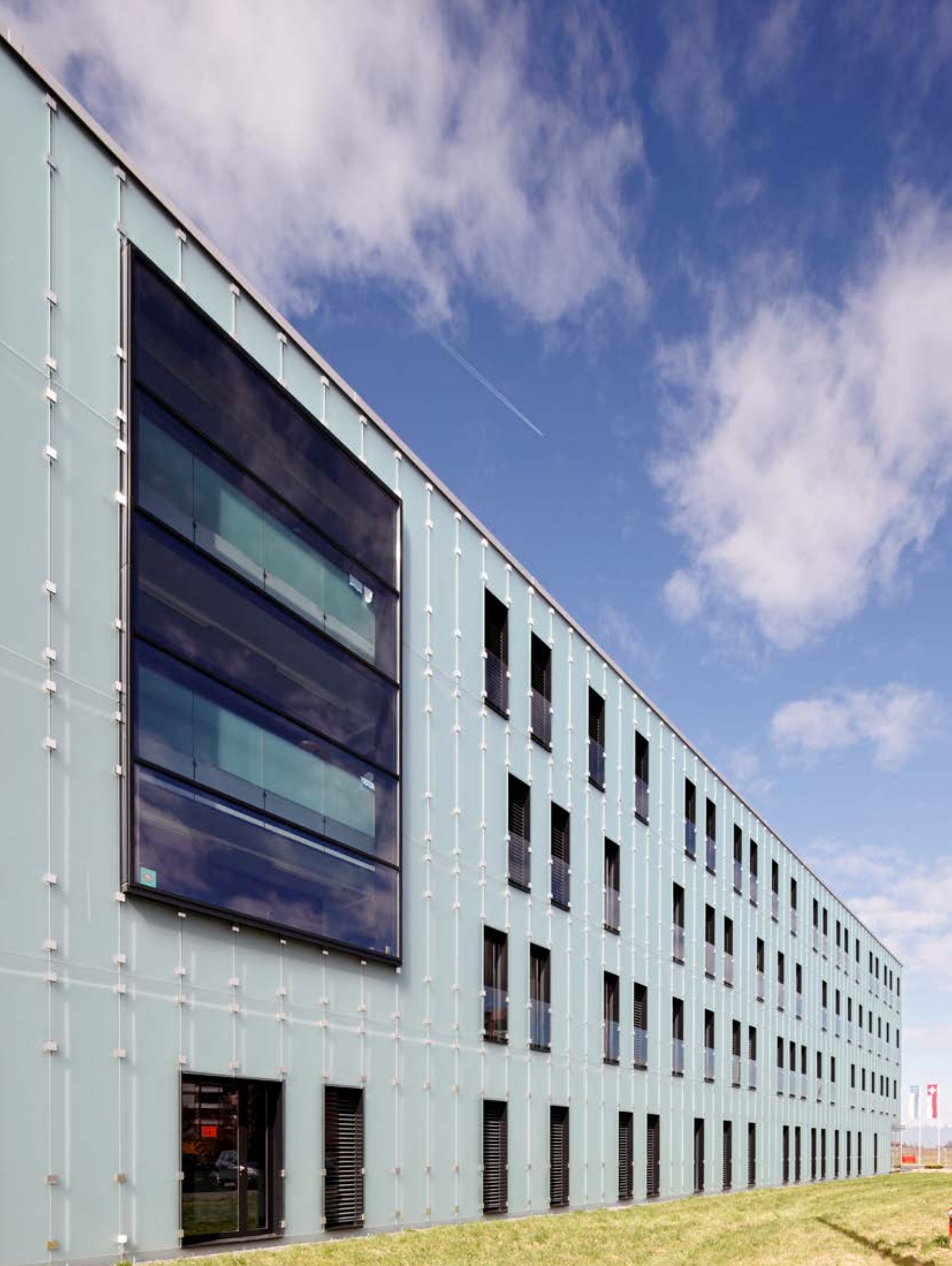
Wärmedämmte Fenster und Verglasungen einbruchhemmend mit Forster thermfix vario und Forster unico – KBA NotaSys SA, Lausanne, Schweiz
