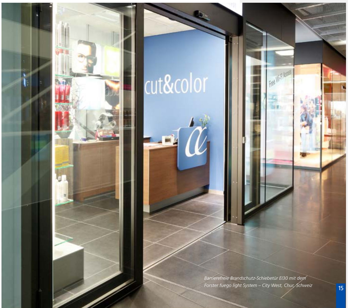
Brandschutzverglasungen EI30 und EI60 / automatische Brandschutzschiebetüren EI30, IKEA, St.Gallen, Schweiz
