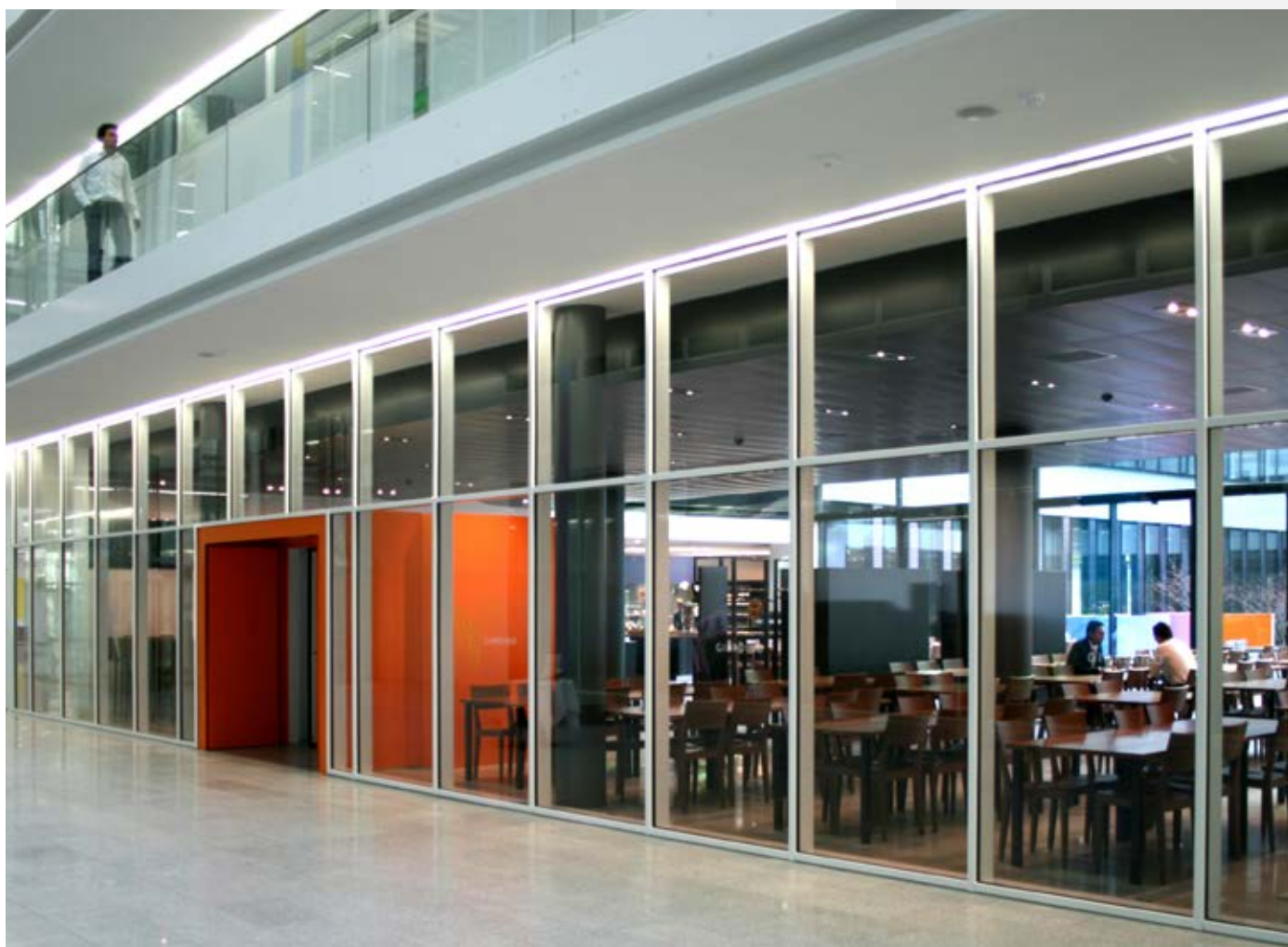
Brandschutzfassade EI60 mit Forster thermfix vario in Edelstahl – Helsana / 2SIDES, Dübendorf, Schweiz
