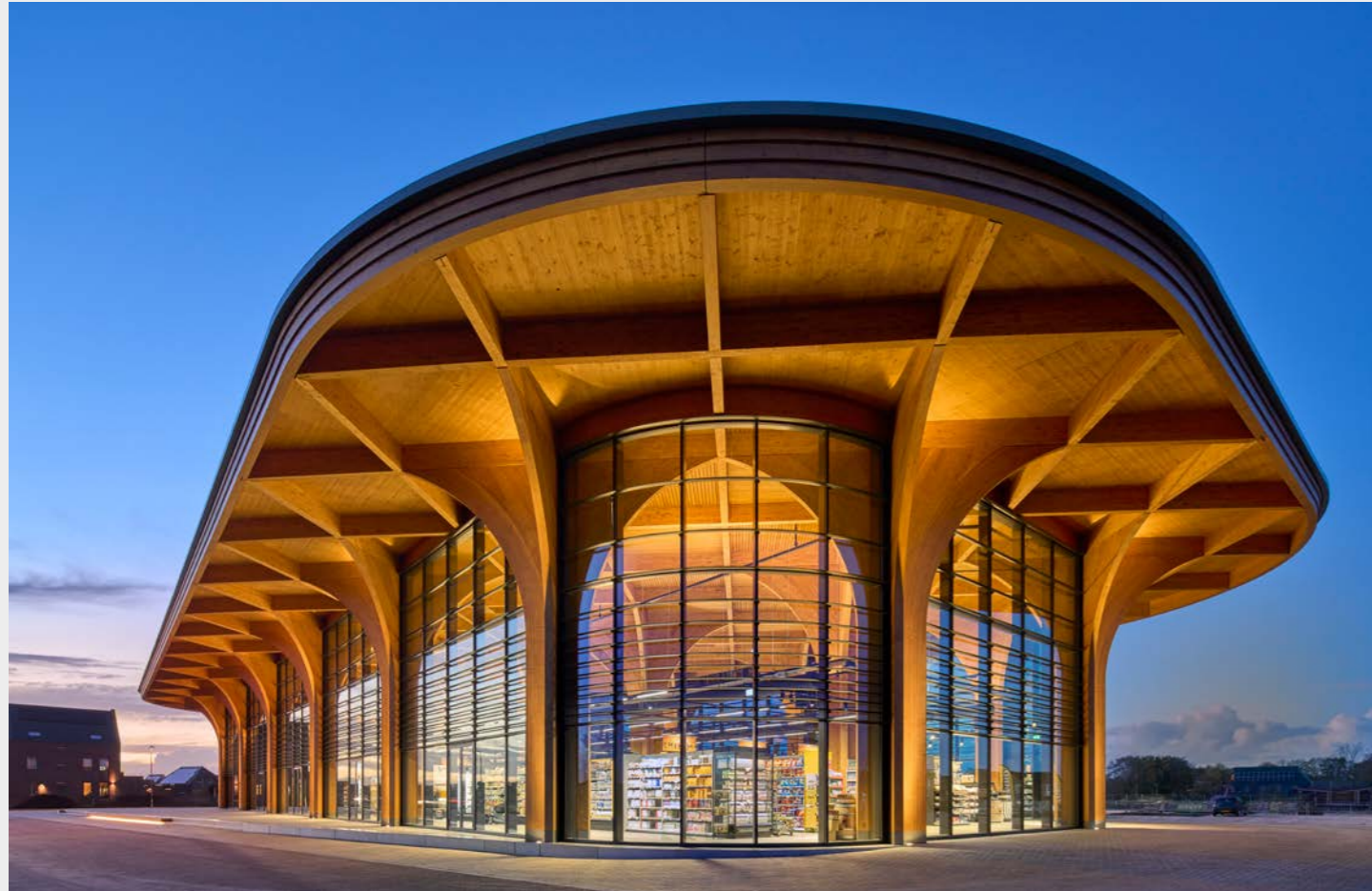
SuperHub Meerstad, Niederlande Wärmegegedämmte Vorhangfassade – forster thermfix vario Wärmegegedämmte zweiflügelige Türen – forster unico Bild: Ronald Tilleman
