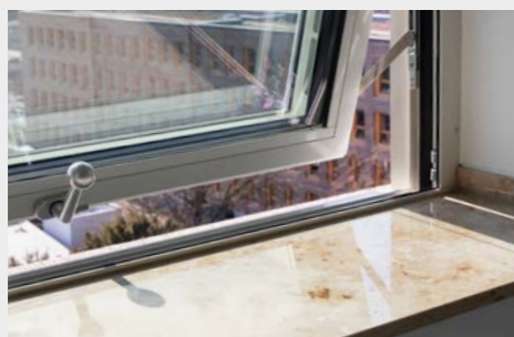
WiSo-Gebäude Universität zu Köln, Deutschland Kastenfenster mit integrierter Tageslichtlenkung – forster unico HI Bilder: Jens Kirchner
