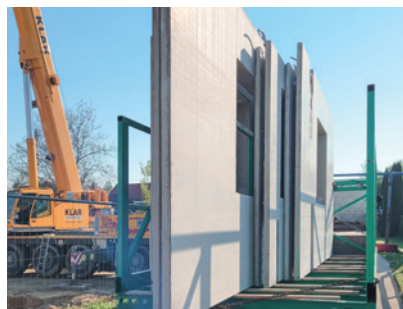
Keine Einschränkung beim Beladen der LKWs, da das Rohbauset bündig eingesetzt ist
