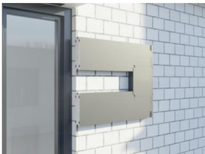
Luftkanäle lassen sich durch ihre geringe Dicke sehr gut in die Außendämmung integrieren
