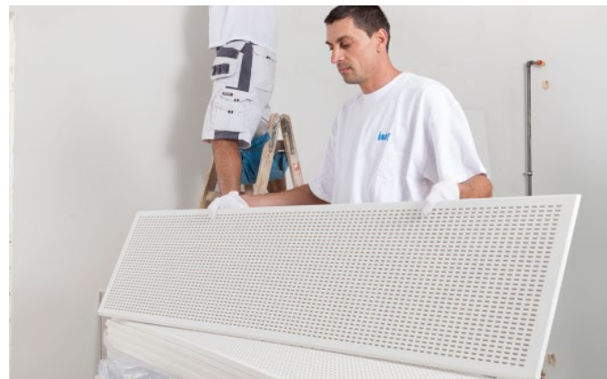
Bild 4: Ablegen der Akustik-Elemente
