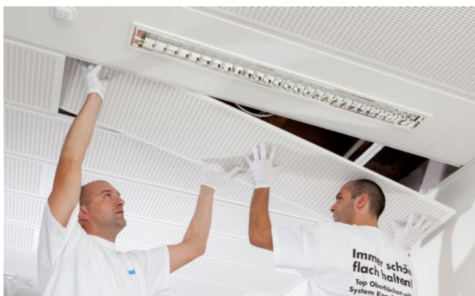
Bild 3: Herausnehmen der Akustik-Elemente
