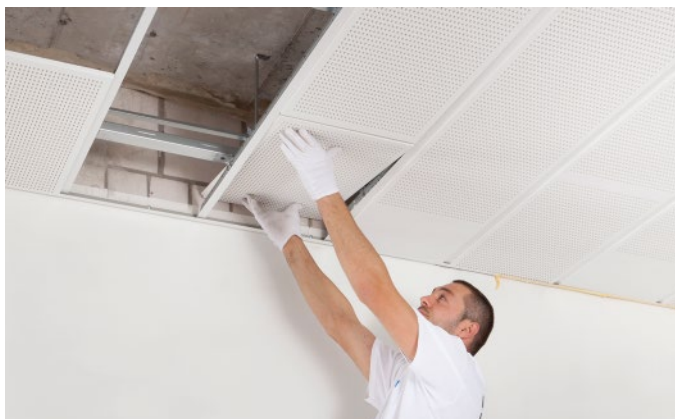
Bild 2: Anheben des ersten Akustik-Elements
