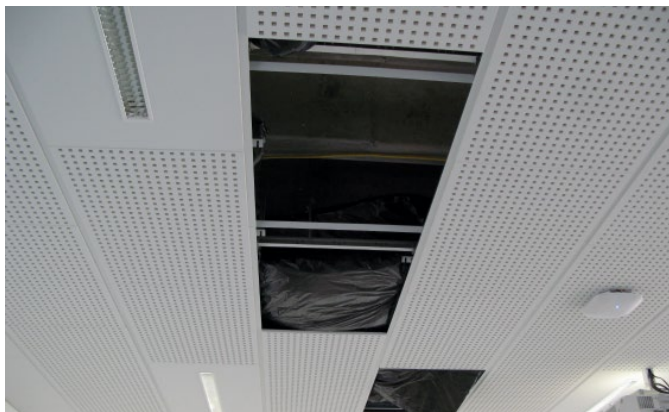
Bild 1: Ansicht Versatz bei der Entnahme von Akustik-Elemente
