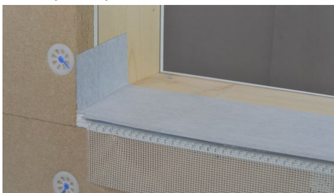
Bild 7: Fertige Verklebung der Fenster-Dichtbahn
