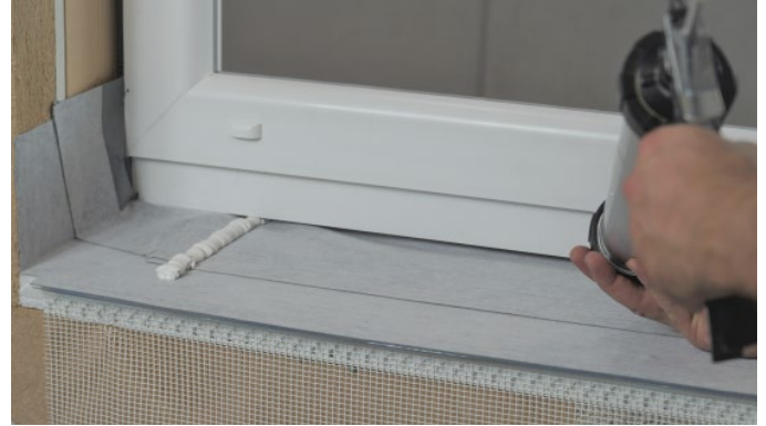
Bild 14: Satte Verklebung Fensterbank
