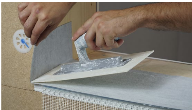
Bild 7: Fertige Verklebung der Fenster-Dichtbahn
