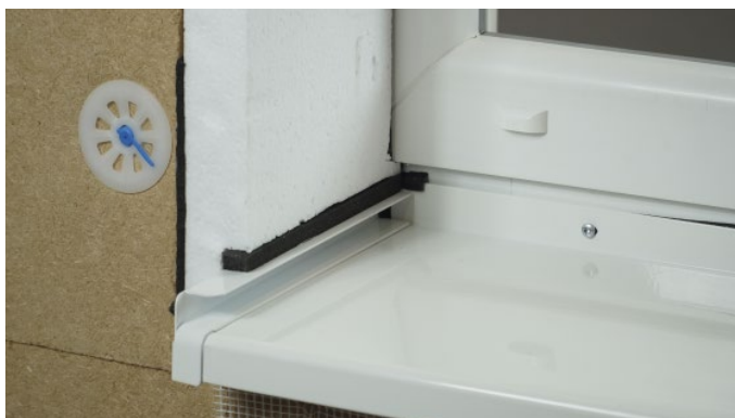
Bild 16: Fertig verklebte Laibungsplatte
