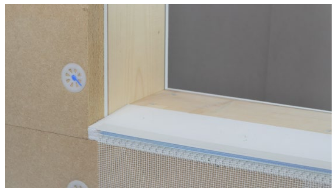
Bild 5: Montage Brüstungsprofil
