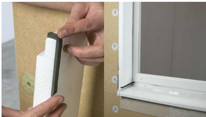
Bild 16: Fertig verklebte Laibungsplatte
