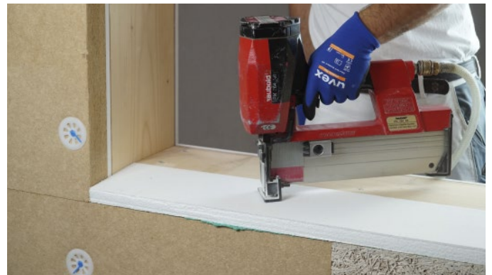
Bild 4: Mechanische Befestigung WARM-WAND Dämmkeil
