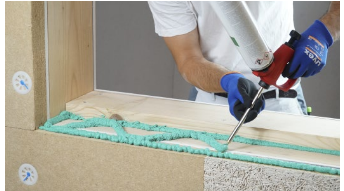
Bild 4: Mechanische Befestigung WARM-WAND Dämmkeil
