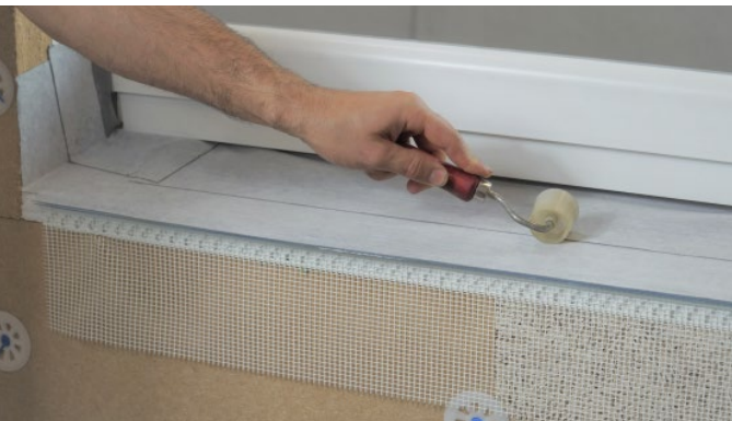
Bild 12: Verkleben Fenster-Anschlussbahn mit Fenster-Dichtbahn
