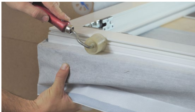
Bild 9: Verkleben Fenster-Anschlussbahn
