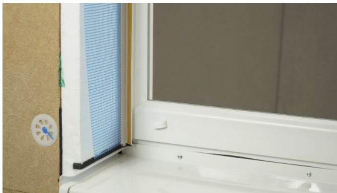
Bild 17: Montage des Fensteranschlussprofils
