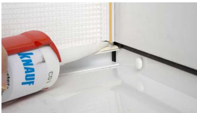
Bild 18: Schließen des Gewerke Lochs
