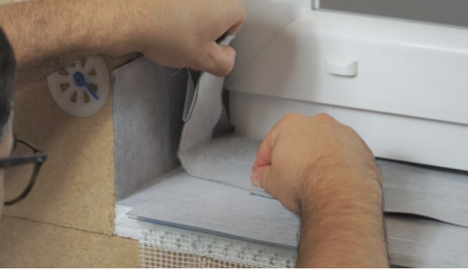
Bild 12: Verkleben Fenster-Anschlussbahn mit Fenster-Dichtbahn
