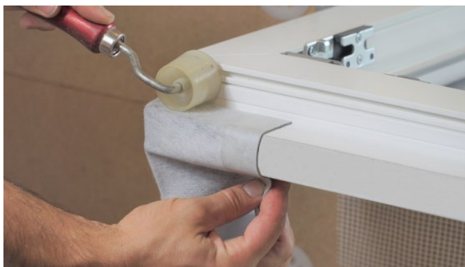
Bild 8: Verkleben der Fenster-Dichtcke
