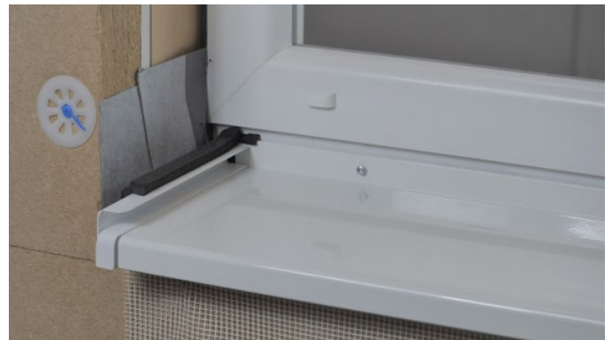
Bild 14: Satte Verklebung Fensterbank
