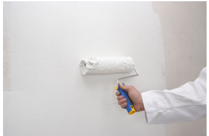
Bild 23: Schlussbeschichtung
