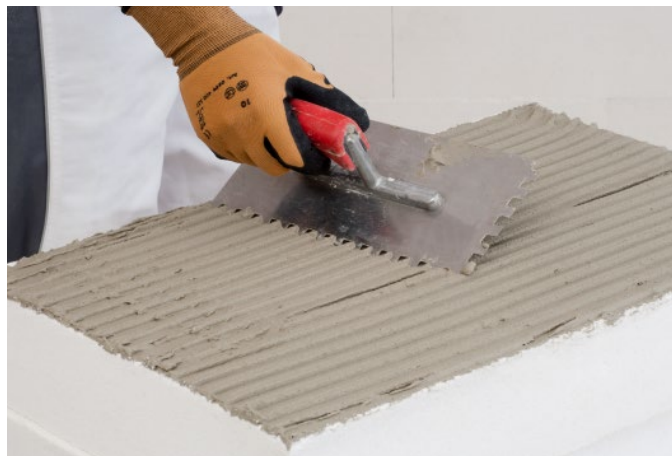
Bild 4: Aufziehen des Rotkalk in-Klebmörtel TecTem
