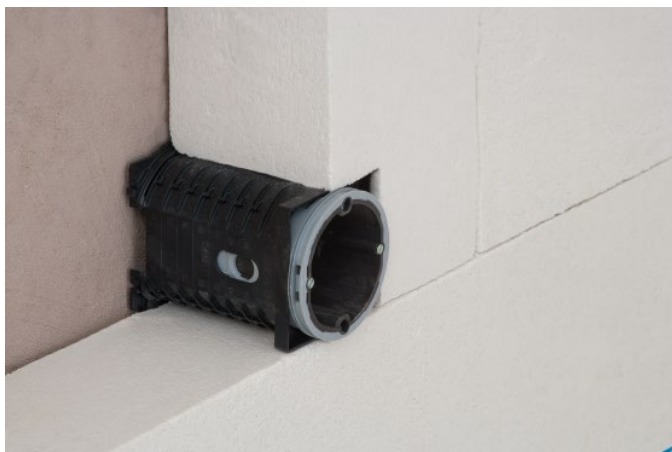
Bild 13: Einbau von Elektrodosen
