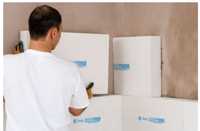
Bild 8: Plattenverlegung im Eckbereich
