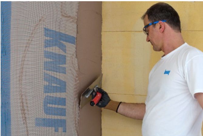
Bild 21: Einbetten des Flächengewebes
