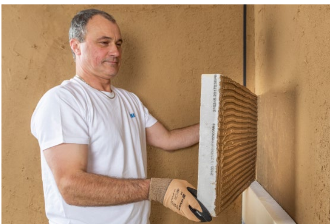
Bild 6: Plattenverlegung in Fläche
