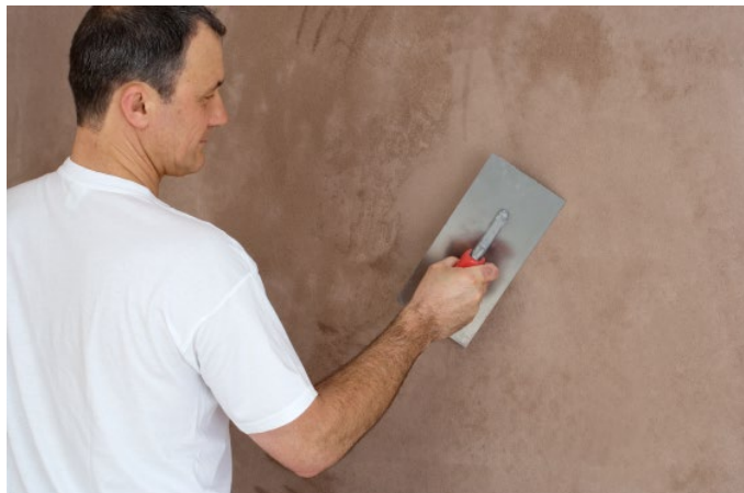
Bild 1: Untergrundvorbereitung von massiven Wänden
