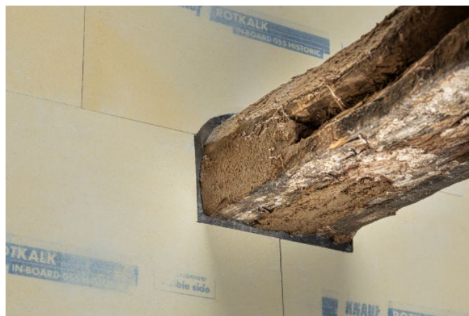
Bild 12: Fachwerk: Bereich Holzbalkendecke
