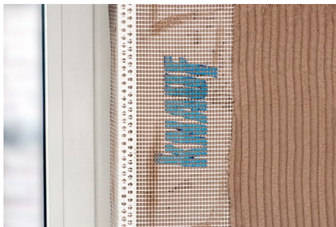
Bild 19: Ausbilden von Öffnungskanten
