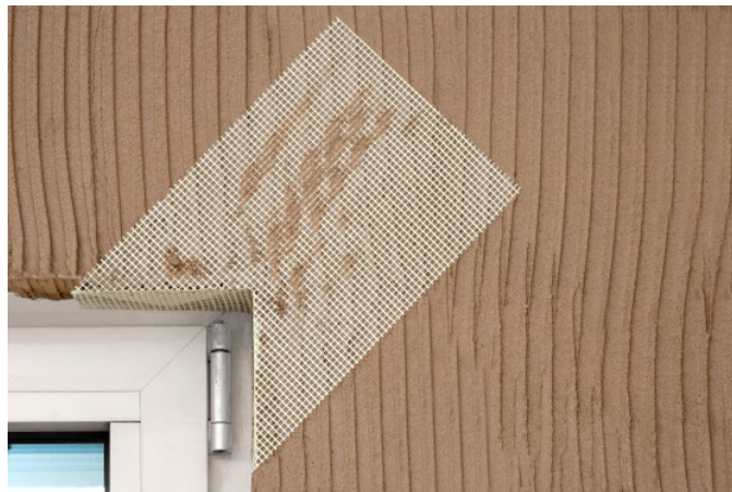
Bild 18: Einbetten von Gewebe an Öffnungsecken
