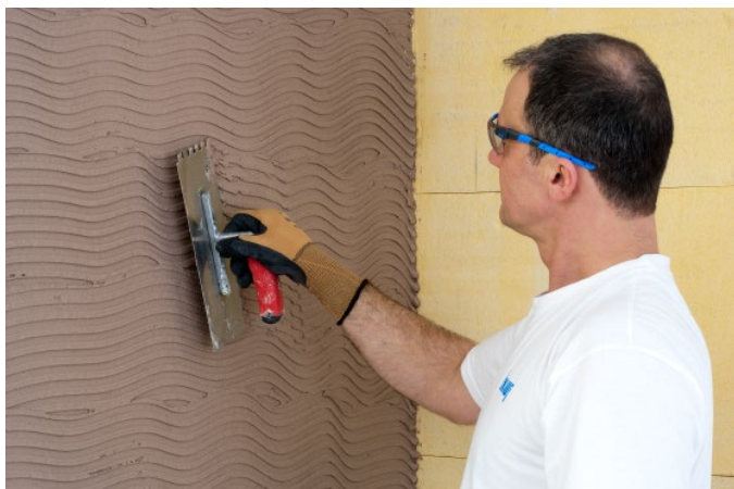
Bild 17: Auftrag der Armierschicht
