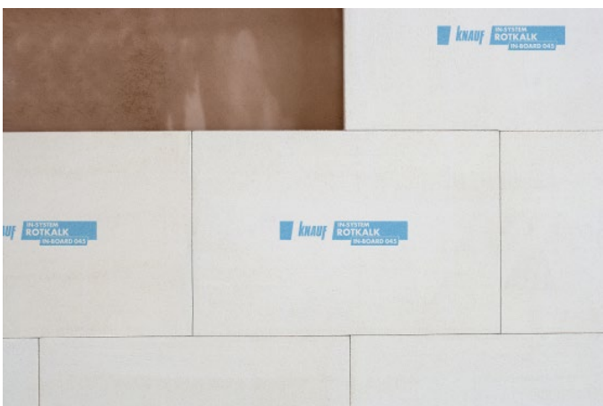
Bild 6: Plattenverlegung in Fläche
