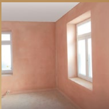
ROTKALK GRUND Kalk-Unterputz mit Kaolin und Ziegelmehl als Unterputz im Innen- und Außenbereich.
