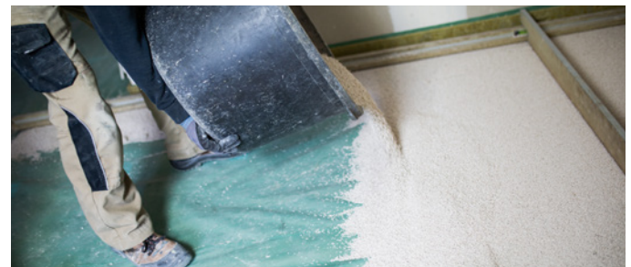
Ausgleichen des Untergrundes mit Knauf Schüttung
