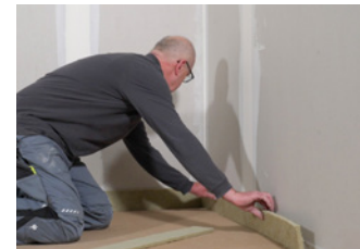
Randdämmstreifen an allen Wänden anbringen. Bei Ausgleich mit Schüttung Randdämmstreifen erst nach der Schüttung anbringen
