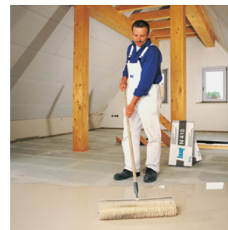
Mit der Stachelwalze wird eine besonders ebene Oberfläche erzielt
