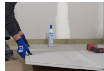
Die nächsten Brio-Elemente werden mit dem oben liegenden Falz in den Kleber eingelegt und ...
