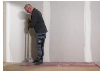
Falls erforderlich, Schüttung verdichten
