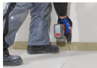
... verschraubt oder verklammert. Für eine sichere Verklebung wird der Elementstoß mit Knauf Brio Schrauben ...
