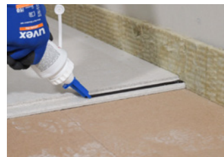
Knauf Brio Falzkleber wird in 2 Schnüren auf den unten liegenden Falz aufgetragen
