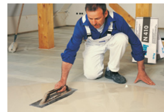
Die fließfähige Spachtel wird mit Traufel ...
