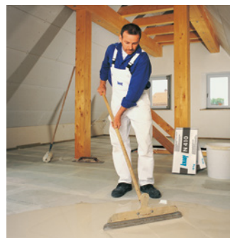
... oder Zahnrakel auf ein gleichmäßiges Niveau gezogen
