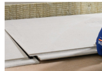
Am Wandanschluss werden die Elemente mit abgeschnittenem Stufenfalz verlegt
