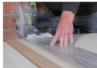
Bei Wandanschluss wird der obenliegende Falz abgeschnitten
