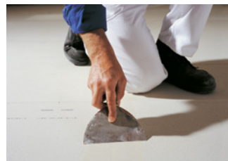
Plattenstöße mit Knauf Uniflott schließen
