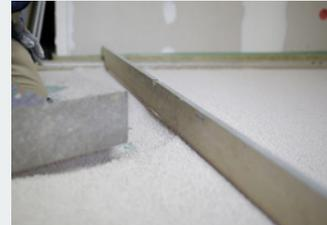
Dann wird die Schüttung abgezogen. Je nach verwendeter Schüttung muss diese abhängig von der Einbauhöhe verdichtet werden. PA zusätzlich verdichten
