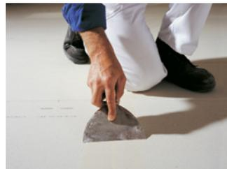
Plattenstöße mit Knauf Uniflott schließen
