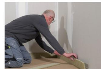
Randdämmstreifen an allen Wänden anbringen. Bei Ausgleich mit Schüttung Randdämmstreifen erst nach der Schüttung anbringen
