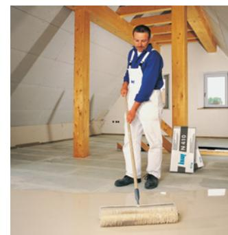
Mit der Stachelwalze wird eine besonders ebene Oberfläche erzielt
