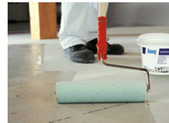
Die Oberfläche wird mit Knauf Estrichgrund (1:1 mit Wasser verdünnt) grundiert
