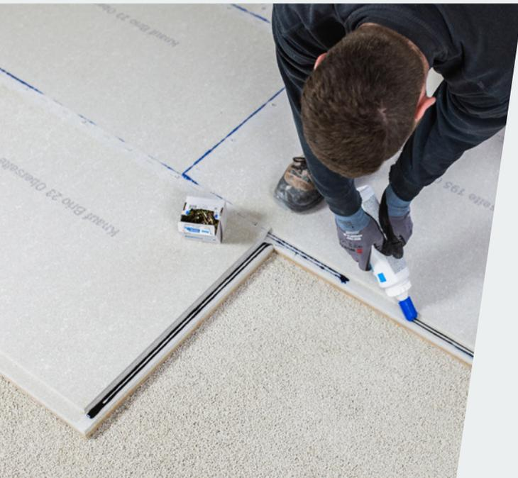
Die Verlegung der Brio-Elemente erfolgt bei Ausgleich mit loser Schüttung vom verlegten Boden aus, damit die Schüttung nicht betreten werden muss
