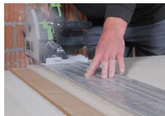
Bei Wandanschluss wird der obenliegende Falz abgeschnitten
