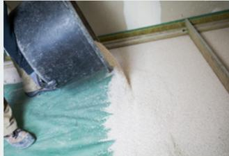
Bei der Verarbeitung von Knauf Schüttungen einen geeignete Abziehlehren verwenden. Diese hinterlassen keine Vertiefungen oder Lücken in der abgezogenen Schüttung
