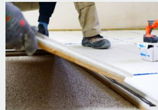
Der obere Falz wird durch das Körpergewicht auf den unteren gepresst ...
