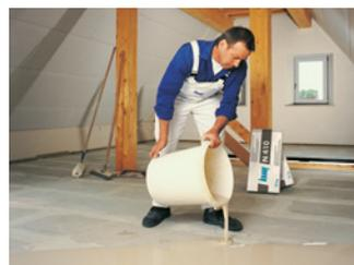
Knauf N 410 ist spannungsarm und ideal zum Spachteln von Trockenestrichen
