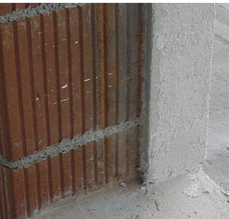
Abb. 1 Rohbausituation vor dem Glattstrich
