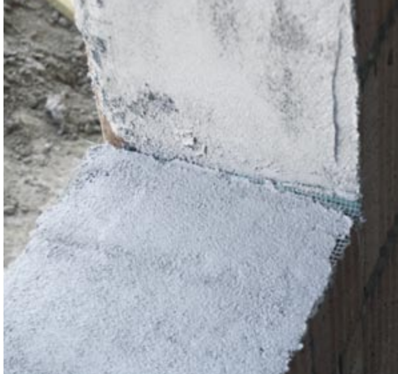
Abb. 2 Rohbausituation mit Glattstrich
