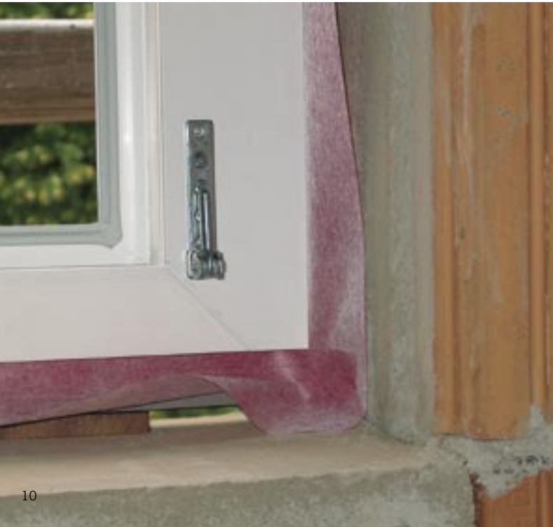
Abb. 8 Eckausbildung mit Fensteranschlussfolie und Klebepaste auf Glattstrich
