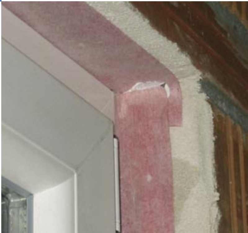
Abb. 8 Eckausbildung mit Fensteranschlussfolie und Klebepaste auf Glattstrich
