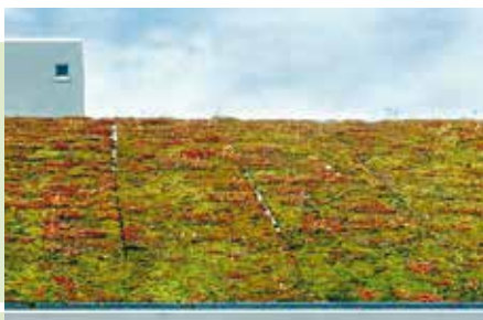
Fugen bei Vegetationsmatten
