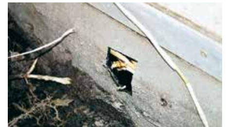
Bereits durch die Abdichtung gewachsene Bambusrhizome
