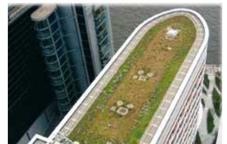
Mit vorbegrüntem Matten im Eck- und Randbereich kann bei exponierter Lage bzw. hohen Gebäuden sofort eine schützende Vegetationsdecke aufgebracht werden.
