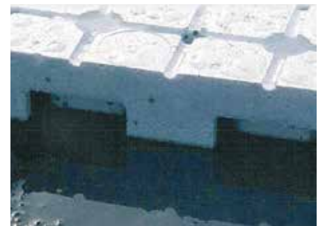
Die Lösung: ausreichend hohe Drainage mit Kapillarbruch.
