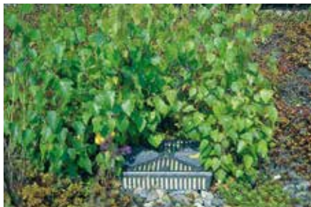
Bei dieser Birke wird es höchste Zeit, dass sie entfernt wird!
