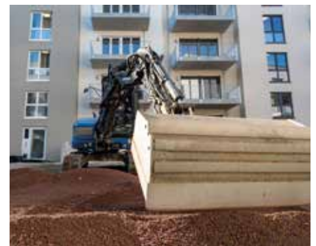
Dank des stabilen-Systemaufbaus mit RSX 80 ist das Befahren mit Baggern zur Substrataufbringung kein Problem. © Straßen- und Tiefbau Urban GmbH
