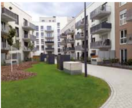
Unter all diesen Grün- und Belagsflächen der Noltemeyer Höfe befinden sich stolze 5780 m 2 Retentionsfläche.
