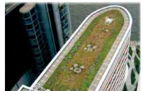
Mit vorbegrüntten Matten im Eck- und Randbereich kann bei exponierter Lage bzw. hohen Gebäuden sofort eine schützende Vegetationsdecke aufgebracht werden.
