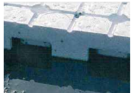
Die Lösung: ausreichend hohe Drainage mit Kapillarbruch.
