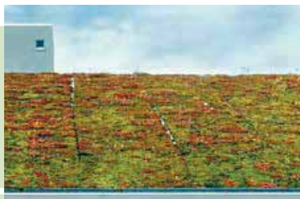
Fugen bei Vegetationsmatten
