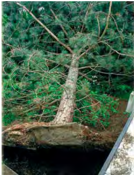
Dieses Nadelgehölz stand zudem dicht am Dachrand – es hielt stärkeren Stürmen nicht mehr stand
