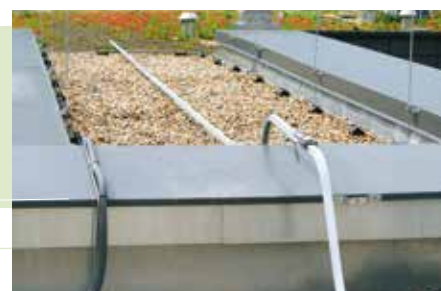
Durch ein S-förmiges Schienenelement kann ein Höhenversprung elegant bewältigt werden, da der Läufer ohne Unterbrechung weiter gleiten kann.
