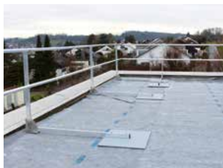
Hier sieht man die Pfostenmodule vor dem Aufbringen des Begrünungs-Systemaufbaus.
