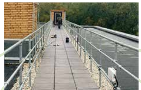
Für die beidseitige Geländereinfassung eines Fluchtweges wird die Pfostenaufnahme der Geländerbasis GB objektspezifisch mit einem zusätzlichen, zweiten Schraubflansch gefertigt.
