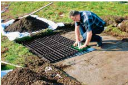
Das Fallnet® SR lässt sich auch in bereits bestehende Begrünungen nachträglich einbauen. Hier wird der Anschlagpunkt in das Rasterelement eingesteckt.
