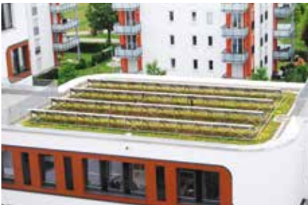
Um Dachflächen bestmöglich auszunutzen, werden Solaranlagen häufig bis nah an den Dachrand gebaut.
