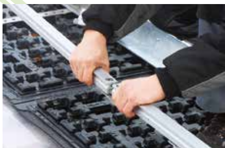
Durch das Baukastenprinzip kann die Absturzsicherung vorteilhaft mit der ZinCo Solarunterkonstruktion kombiniert werden.
