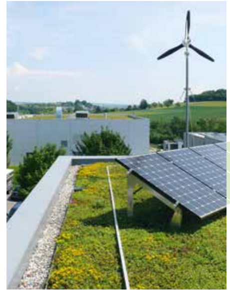
Das klassische Einsatzgebiet des Fallnet®-Schienensystems: Randbereiche, an denen immer wieder gearbeitet werden muss. Einmal im Läufer eingeklinkt, sind sämtliche Tätigkeiten absolut sicher auszuführen.
