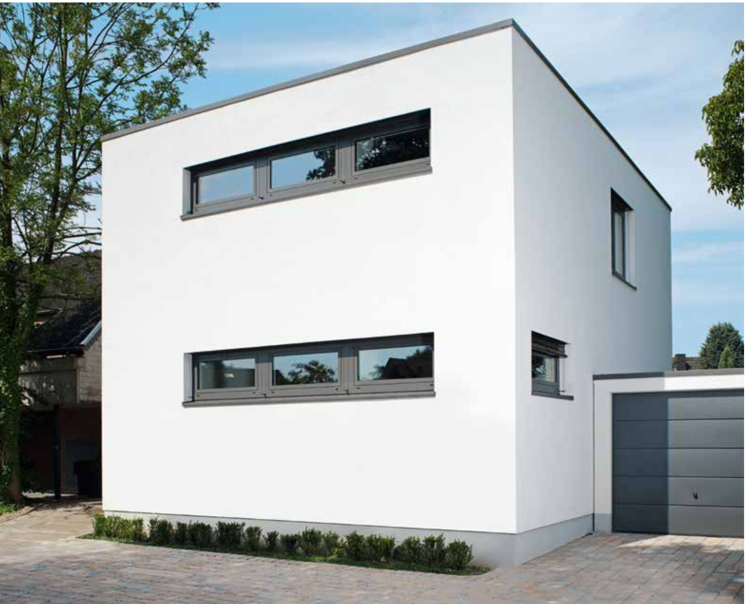
Fenster sind dominante Gestaltungselemente.
