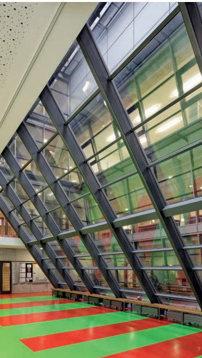
Hafencity Schule, Hamburg/DE (VISS Fire E30 vertikal und schräg, Janisol Türen) Hafencity school, Hamburg/DE (VISS Fire E30 vertical and sloping, Janisol doors)
