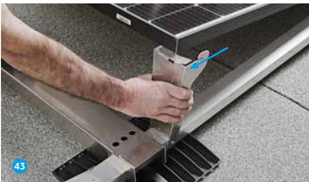
Lasche des Heckträgers in den Modulrahmen schieben.
