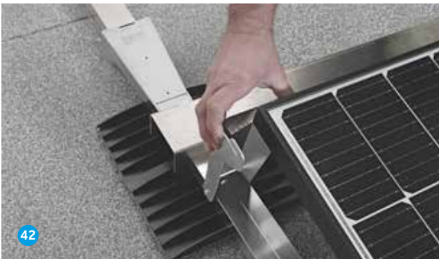
Äußeren Heckträger aufrichten. Heckträger zwischen den Modulen noch nicht aufrichten.
