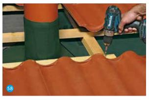
Traufseitige Traglatte 30/50 mm auf Konterlatte befestigen, als Auflager für Schalung um das Abgasrohr.
