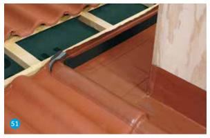
Schaumstreifen in Kehlbreite aufkleben. Positionierung zwischen Fußrippen der überdeckenden Harzer Pfanne F<sup>+</sup>
