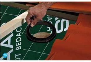
Anschlussring des DuroVent Anschluss-Sets DN 125 im Uhrzeigersinn in Divoroll Premium WU eindrehen. Elastischen Ring dazu hochklappen. Anschließend wieder herunterklappen.
