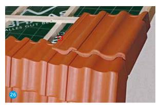
• Dachstein-Reihe oberhalb der Mansardsteine F<sup>+</sup> verklammern, zumindest im Bereich des halben Mansardsteines F<sup>+</sup>.
