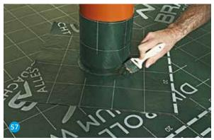
Schweißkanten Divoroll- Streifen und Wülste mit Divoroll Dichtpaste zusätzlich sichern.
