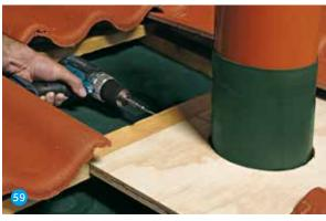
Traglatte 30/50 mm hinter Abgasrohr dient als firstseitiger Befestigungspunkt für die Kehlschalung aus Holzwerkstoffplatten um das
