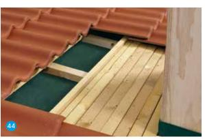
Hinter dem Kamin Unterstützungslatte 30/50 mm hochkant anbringen, als Auflage der Dachstein-Reihe, so dass sie die gleiche Neigung aufweisen wie in der Fläche.
