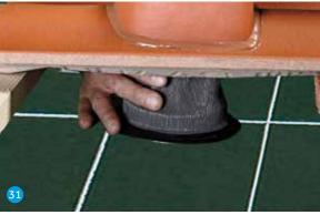
• Flexiroll Alu am Anschlussrohr dicht verkleben.
