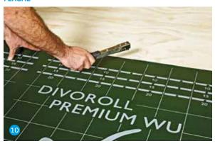
• Die nächste Bahn parallel zur Traufe ausrollen, faltenfrei ausrichten und im oberen Drittel der Überlappung befestigen.
