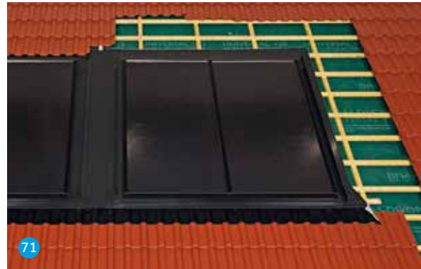
Beidecken des Kollektorfeldes
