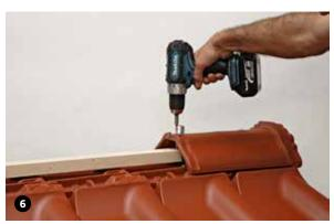
Zusätzliche Firstklammer HO + N auf der Firstlatte festschrauben, Einschraubtiefe mind. 24 mm.
