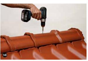
Den Sattelfirstausgleich mit einer Spenglerschraube zusätzlich sichern, Einschraubtiefe mind. 24 mm.
