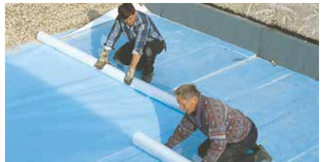
Abb. 22: Verlegung der Trennlage
