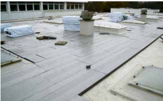
Abb. 43: XPS Platten werden im Verband verlegt, die Anschlüsse an Lichtkuppeln sind exakt anzuarbeiten
