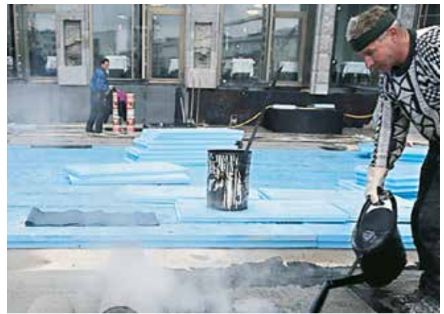
Abb. 11: Verlegebeispiel einer bituminösen, vollflächig verklebten Abdichtung
