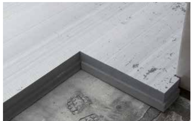
Abb. 13: Die RAVATHERM™ XPS X Platten werden lose und im Verband auf der Abdichtung verlegt
