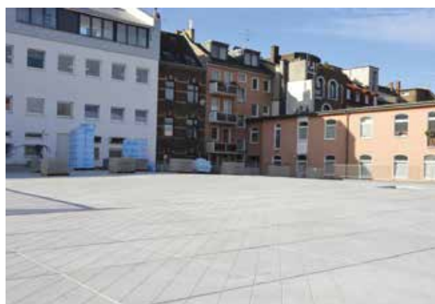
Abb. 26: Befahrbares Umkehrdach
