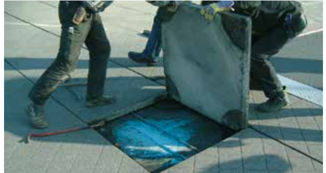
Abb.49: Entnahme der blauen XPS Dämmplatte ...
