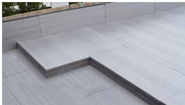
Abb. 27: Attika-Anschluss mit RAVATHERM™ XPS X
