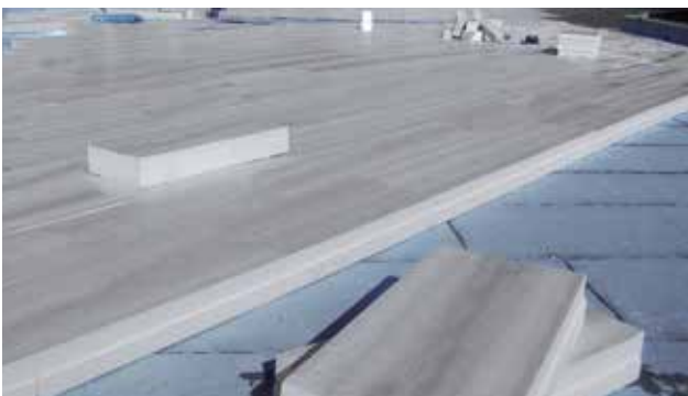
Abb. 45: XPS Platten werden lose verlegt
