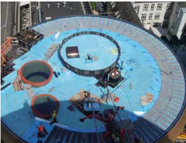
Abb. 16: XPS-Dämmplatten auf dem Dach vom Axeltorv-Haus, Kopenhagen
