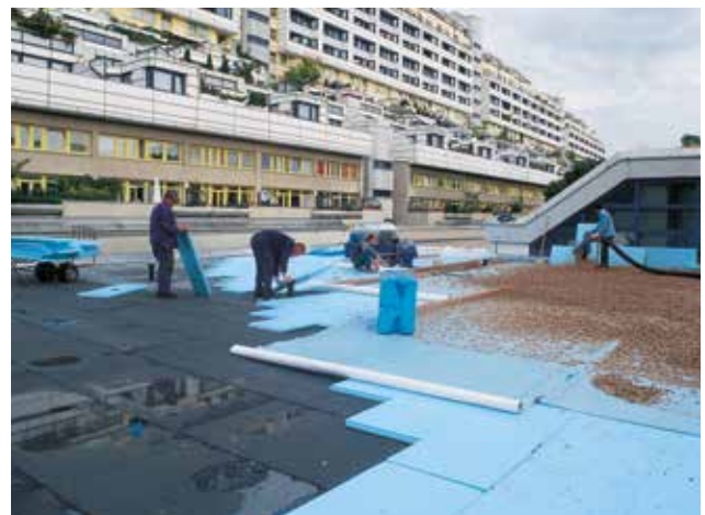
Abb. 40: XPS-Wärmedämmung, Trennlage und Kiesschicht werden auf der neuen Abdichtung verlegt
