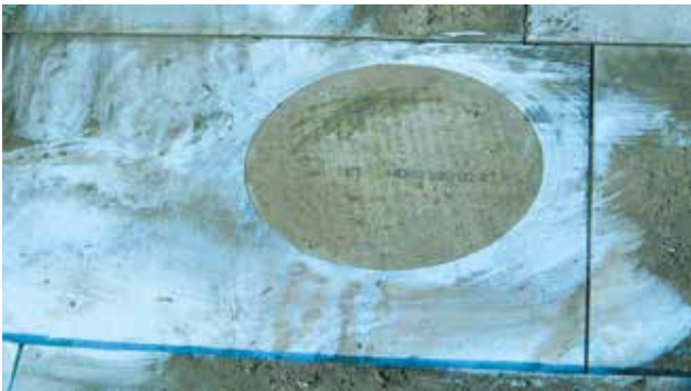
Abb.50: ... aus einem Fertigteilplatten-Parksystem
