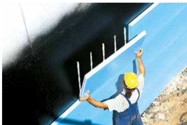
Abb. 25: Verlegung der XPS Dämmung auf der abgedichteten Kellerwand
