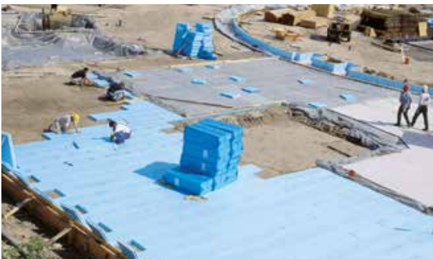
Abb.09: XPS Dämmplatten lose auf der Beton-Sauberkeitsschicht verlegt
