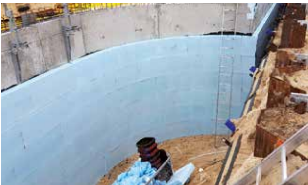
Abb.11: Dämmplatten auf der Kelleraußenwand verklebt
