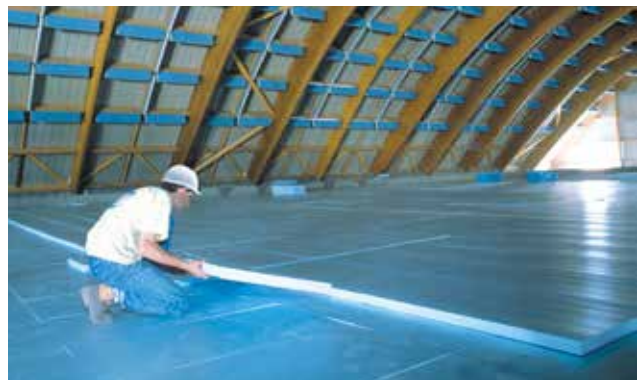
Abb. 45: XPS-Bodendämmung in einer Sporthalle
