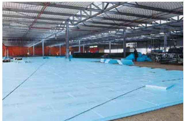
Abb. 39: XPS Bodendämmung in einer Werkshalle
