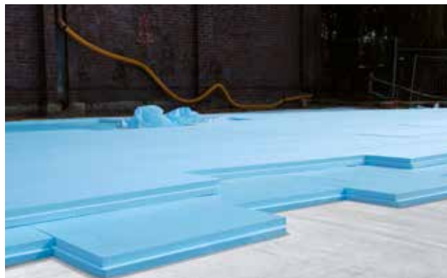
Abb. 18: Zweilagige Verlegung der Dämmplatten auf Sauberkeitsschicht in Beton
