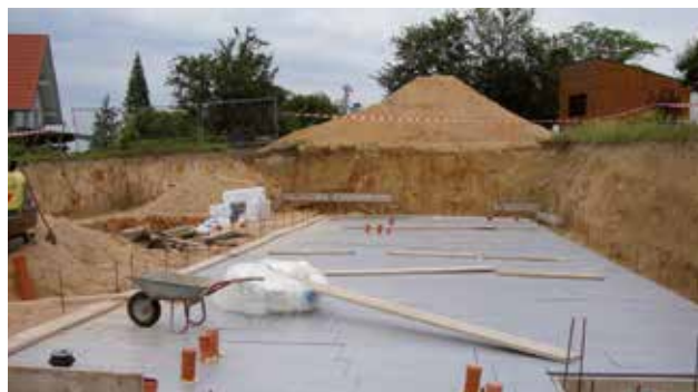
Abb. 19: Verlegung XPS-Dämmplatten unter lastabtragender Bodenplatte
