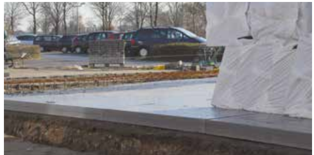
Abb. 26: Die grauen XPS-Dämmplatten (unter der Kellersohle) werden auf der Sauberkeitsschicht verlegt
