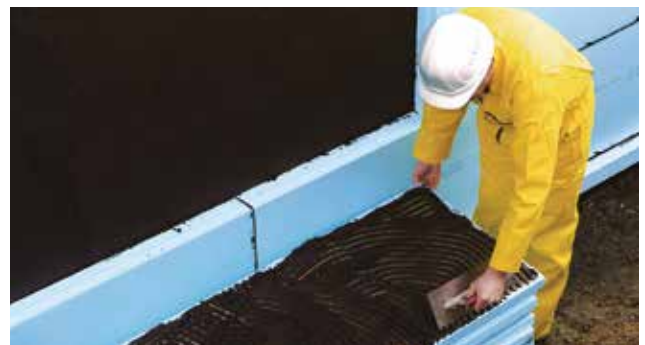
Abb. 32: Vollflächige Verklebung der blauen XPS Dämmung
