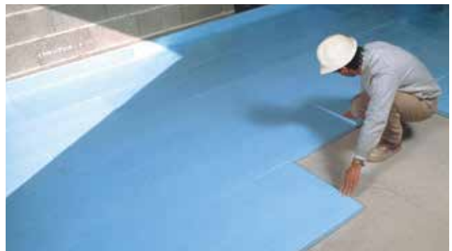
Abb. 46: XPS-Bodendämmung in einer Sporthalle
