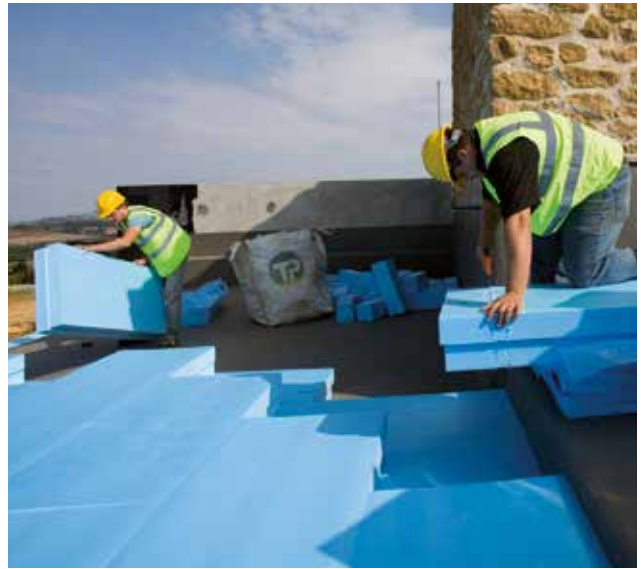
Abb. 21: Die doppellagige Verlegung von XPS Platten auf einer Sauberkeitsschicht aus Beton
