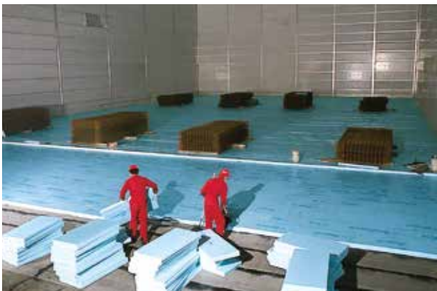
Abb. 38: XPS Bodendämmung in einem Tiefkühlhaus
