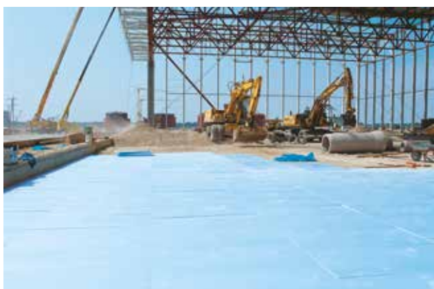
Abb. 02: Blaue XPS Dämmung unter hochbelasteter Bodenplatte einer Lagerhalle
