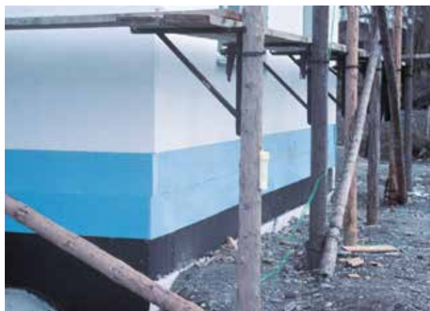
Abb. 43: XPS-Sockeldämmung im Spritzwasserbereich
