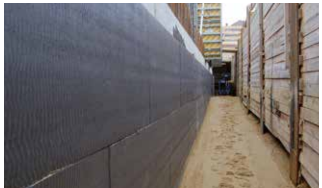
Abb.10: Graue XPS Dämmplatten auf der Kelleraußenwand verklebt
