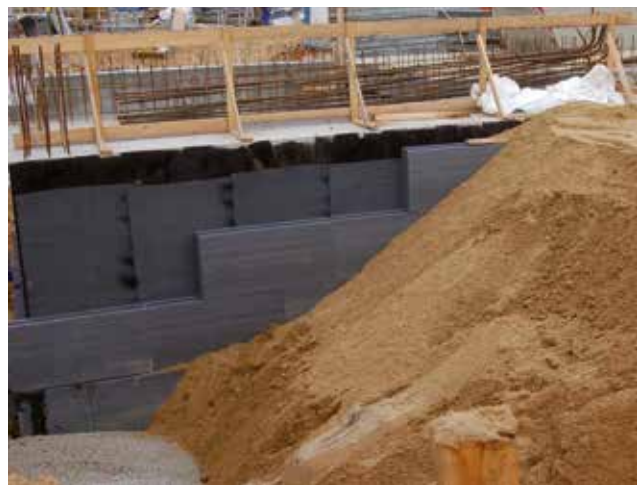
Abb. 17: Verklebung der XPS Dämmplatten auf der abgedichteten Kelleraußenwand
