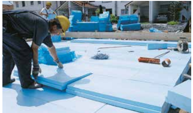
Abb.08: Blaue XPS Dämmplatten mehrlagig auf das Feinplanum verlegt
