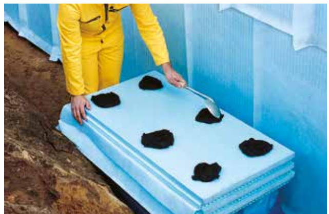
Abb. 28: Punktweise Verklebung der Perimeterdämmung
