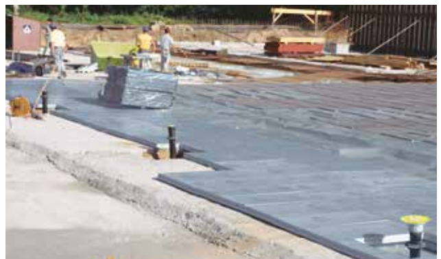
Abb.12: Dämmplatten auf der Beton-Sauberkeitsschicht verlegt
