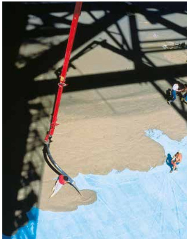
Abb. 41: Die Bodenplatte wird auf den blauen XPS-Platten, abgedeckt mit PE-Folie, betoniert
