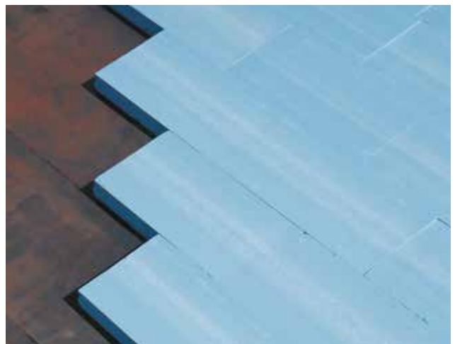
Abb. 17: Umkehrdach auf bituminöser Abdichtung
