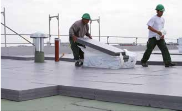
Abb. 14: RAVATHERM™ Platten werden zweilagig verlegt
