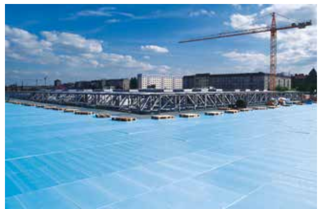
Abb. 10: Die XPS-Dämmplatten schützen während der Bauzeit die darunter liegende Abdichtung
