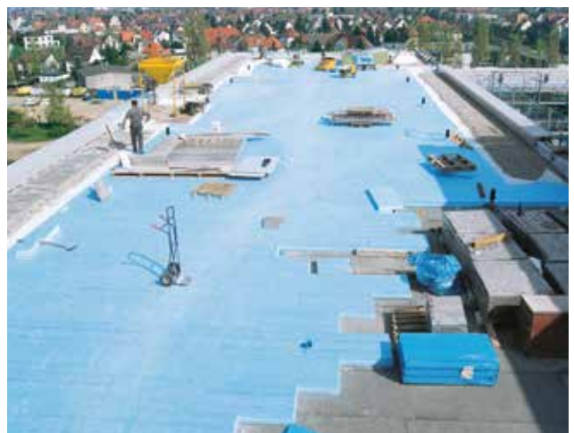
Abb. 19: Verlegung von XPS Platten im Verband. Die Windsogsicherung wird im Randbereich aufgebracht.
