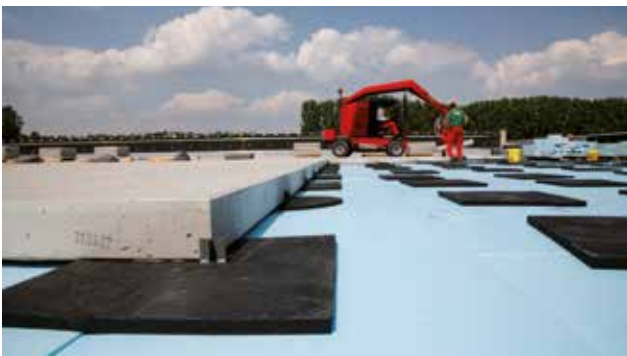
Abb. 36: Verlegung der System-Beton-Fertigteil-Platten und der Plattenträger auf RAVATHERM™
