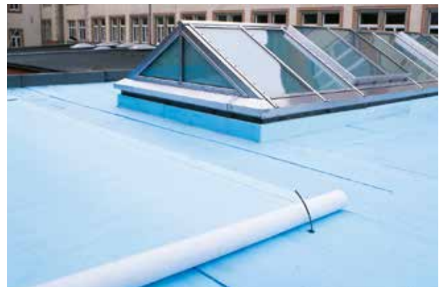
Abb. 28: Lose Verlegung der Trennlage
