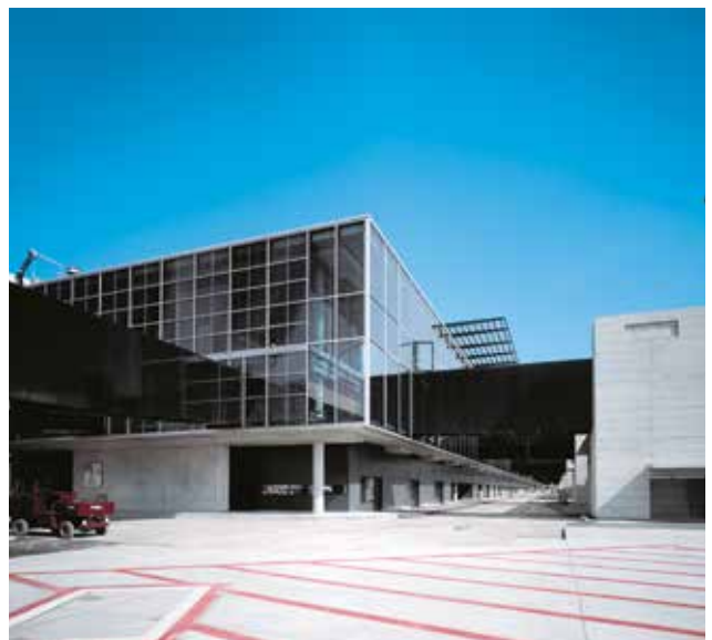
Abb. 39: Hochbelastete, befahrbare Flächen als Umkehrdach auf dem Vorfeld des Flughafens in Zürich
