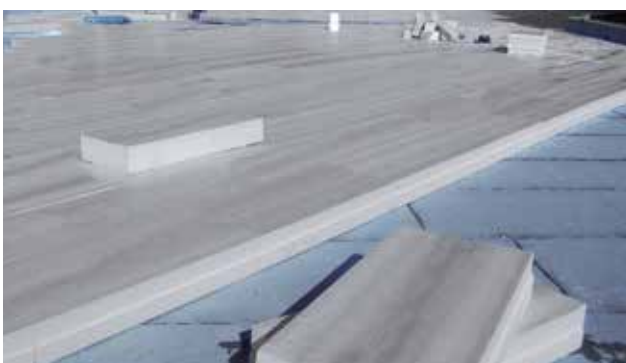
Abb. 45: XPS Platten werden lose verlegt
