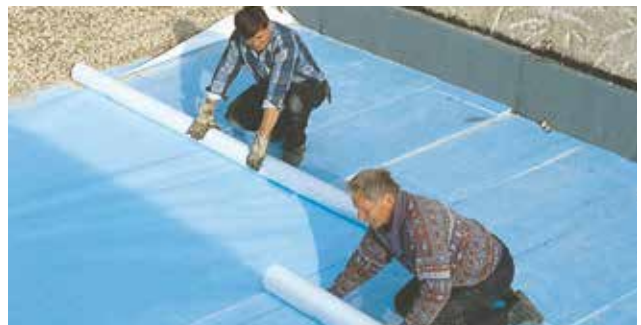
Abb. 22: Verlegung der Trennlage
