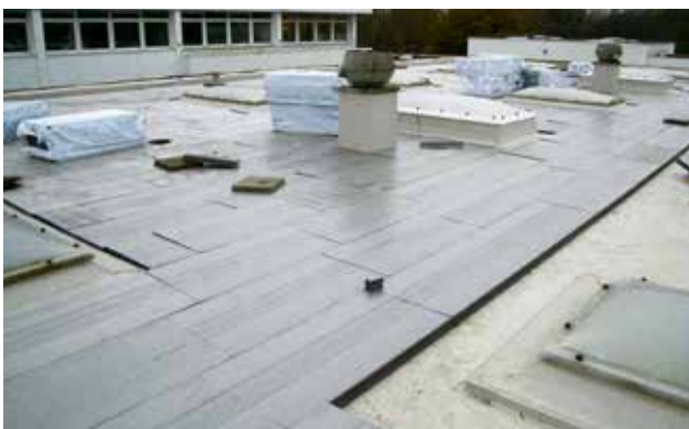
Abb. 43: XPS Platten werden im Verband verlegt, die Anschlüsse an Lichtkuppeln sind exakt anzuarbeiten
