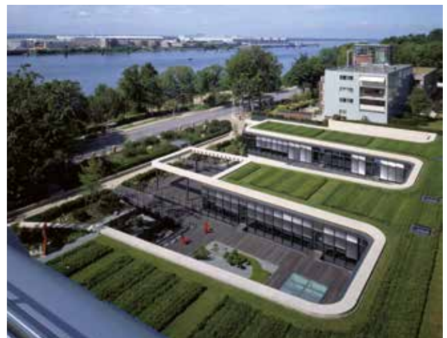
Abb. 35: Intensiv begrünte Umkehrdächer (in WU-Beton-Bauweise) – ESD Bürowelten, Hamburg
