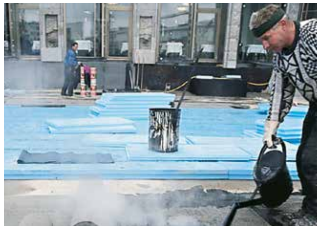
Abb. 11: Verlegebeispiel einer bituminösen, vollflächig verklebten Abdichtung
