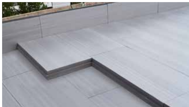
Abb. 27: Attika-Anschluss mit RAVATHERM™ XPS X
