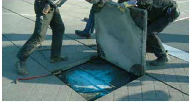
Abb.49: Entnahme der blauen XPS Dämmplatte ...
