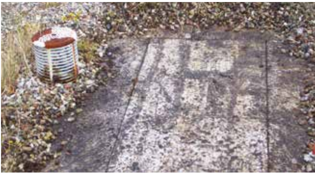
Abb. 46+47: Entnahme einer 32 Jahre alten XPS-Dämmplatte aus dem bekiesten Umkehrdach des Verwaltungsgebäudes der Hamburg-Mannheimer Versicherungs AG.
