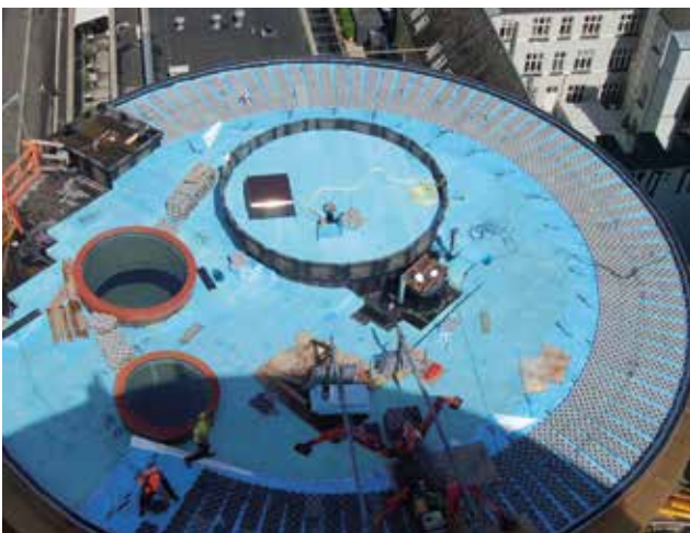
Abb. 16: XPS-Dämmplatten auf dem Dach vom Axeltorv-Haus, Kopenhagen
