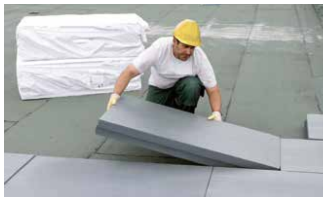
Abb. 44: XPS Platten lassen sich leicht handhaben
