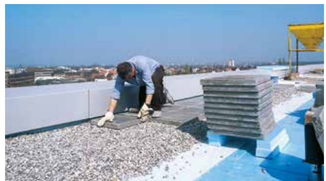
Abb. 29: Die Windsogsicherung aus Kies und Betonplatten wird verlegt
