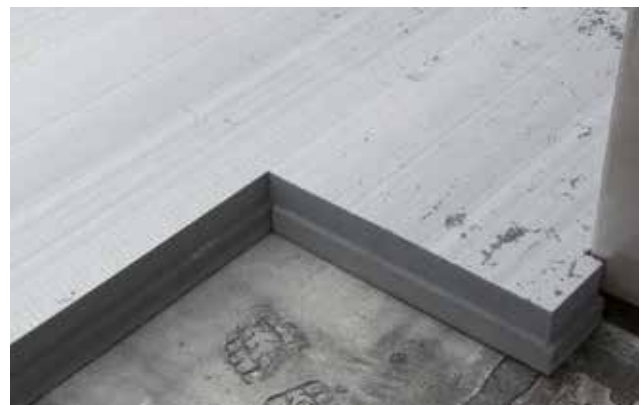
Abb. 13: Die RAVATHERM™ XPS X Platten werden lose und im Verband auf der Abdichtung verlegt
