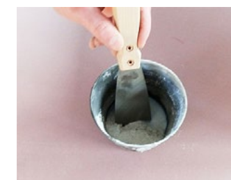
4. Rühren der Mischung (Verhältnis zw. der flüssigen Seife und dem Wasser 1:10).t
