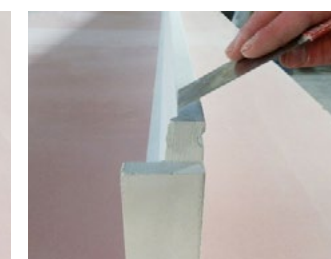
10. Handelt es sich um „größere“ Reparaturen, sollte der Zementkitt in mehreren Schichten aufgetragen werden.
