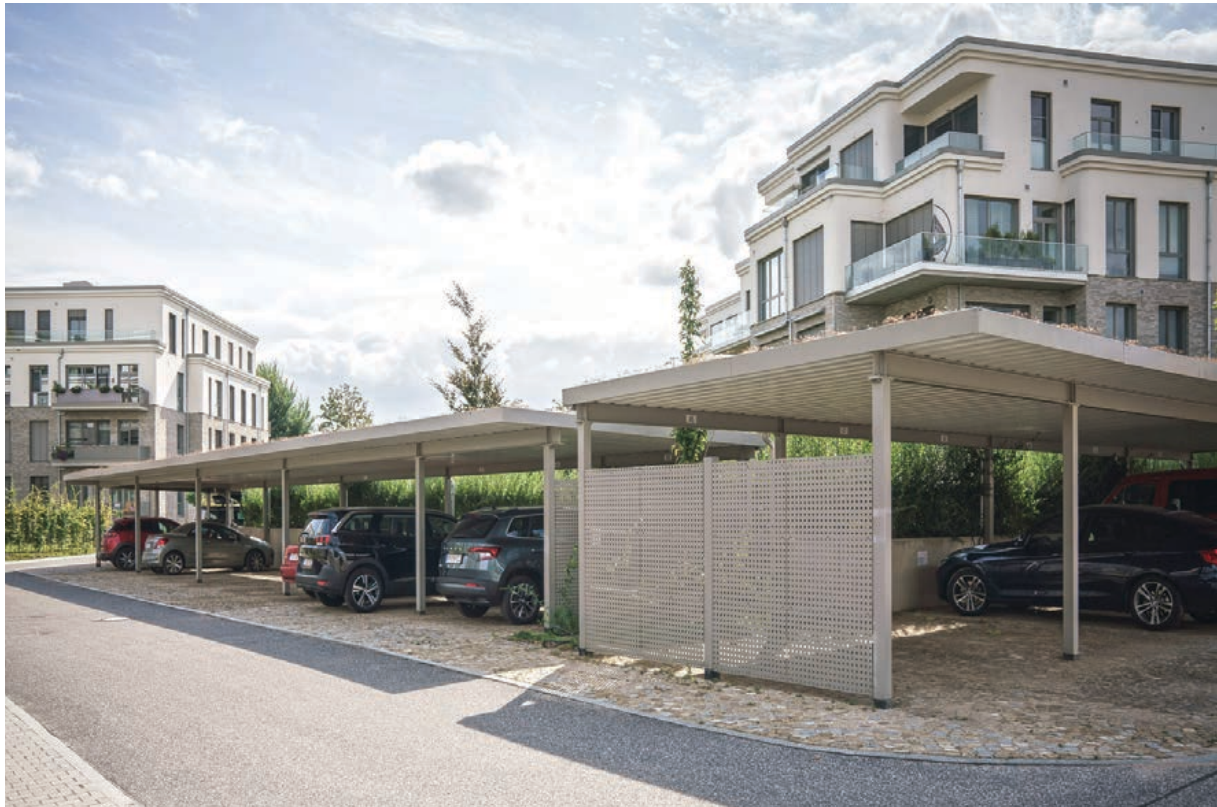
Carportanlagen und Müllhäuser , Stützen und Seitenverkleidung ALU-Lochblech nach RAL 7030 Steingrau pulverbeschichtet, Gründach Light.
