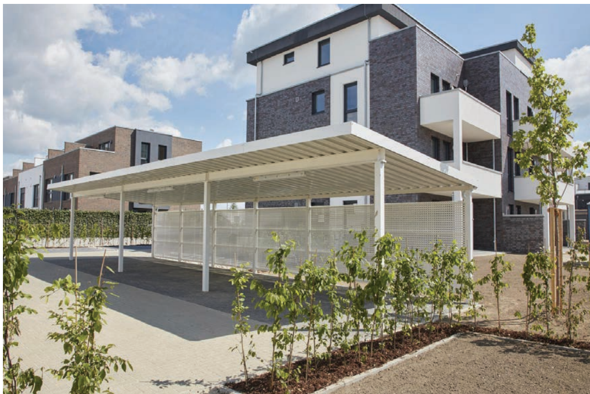
Carportanlage , Stützen und Seitenwände aus Lochblech nach RAL 9010 Reinweiß pulverbeschichtet, Trapezblechdacheindeckung.
