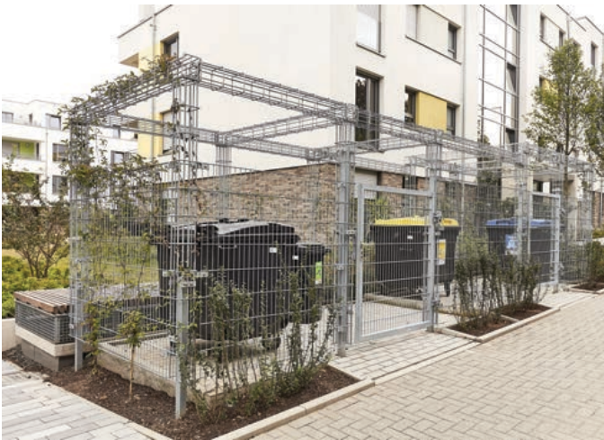
Müllplatz , Tragkonstruktion Drahtbalken.
