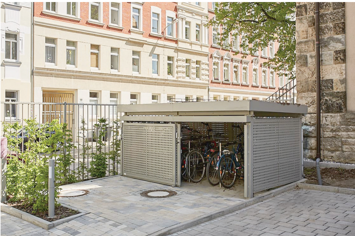
Fahrradgarage , Stützen und Seitenverkleidung aus ALU-Lochblech nach RAL 7030 Steingrau pulverbeschichtet, Hängeschiebetore und Gründach Light.
