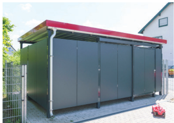
Müll- und Abstellhaus , Stützen und Traversen nach RAL7016 Anthrazit pulverbeschichtet, Attika nach RAL 3003 Rubinrot pulverbeschichtet, Seitenverkleidung Trespa A25.8.1 Anthrazitgrau, Hängeschiebetore.
