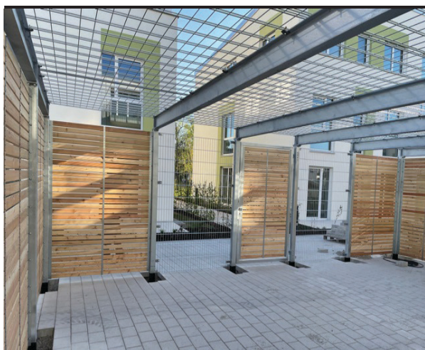
Mülleinhäusung mit Gittermattendach.
