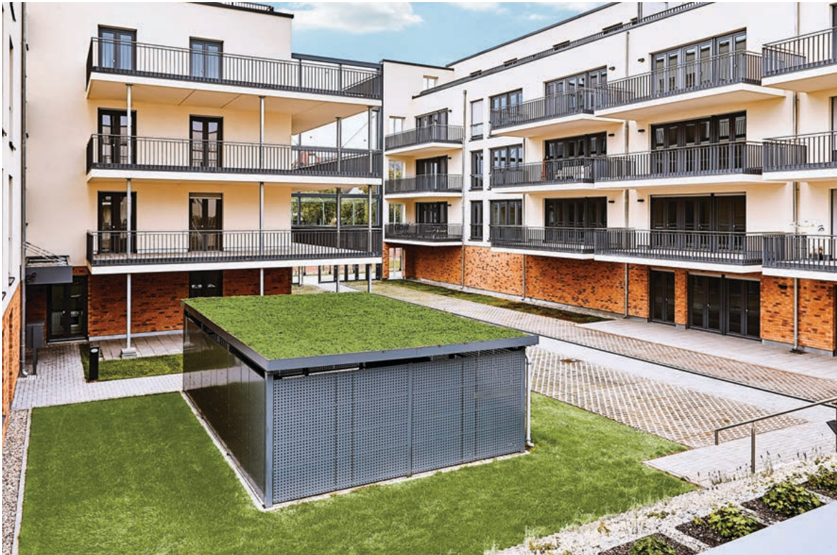
Mülleinhausung , Stützen und Seitenverkleidung ALU-Lochblech nach RAL 7012 Basaltgrau pulverbeschichtet, Gründach Light.
