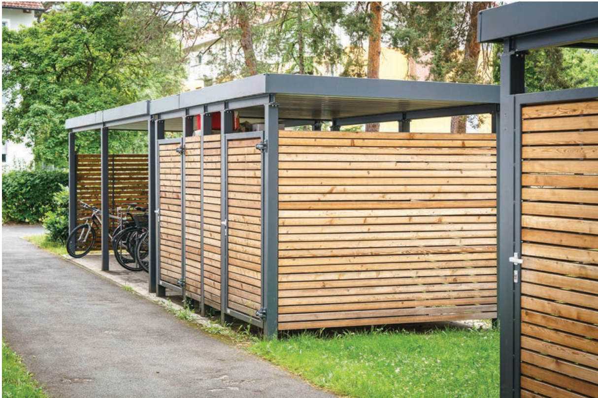
Fahrradüberdachung und Mülleinhausung , Stützen nach RAL 7011 Eisengrau pulverbeschichtet, Seitenverkleidung Woodline.
