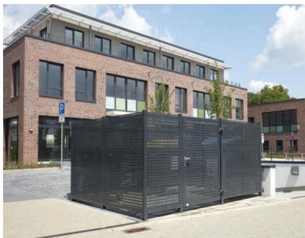
Müllplatz , Stützen und Seitenverkleidung ALU-Lochblech nach RAL 7016 Anthrazit pulverbeschichtet.
