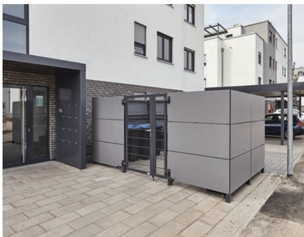
Müllplatz , Stützen RAL 7016 Anthrazit pulverbeschichtet, Seitenverkleidung Trespa, Flügeltor Gittermatte.
