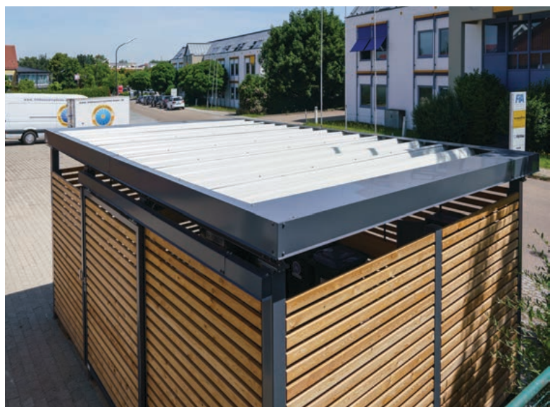
Müllhaus mit Trapezblechdach.
