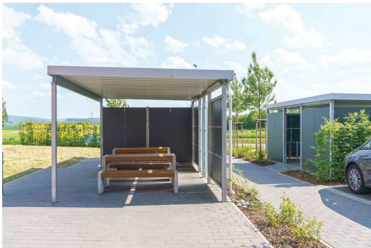
Überdachung und Fahrrad einhausung , Stützen verzinkt, Seitenwände TRESPA® METEON® UNI QUARTZ GREY, Trapezblechdacheindeckung.
