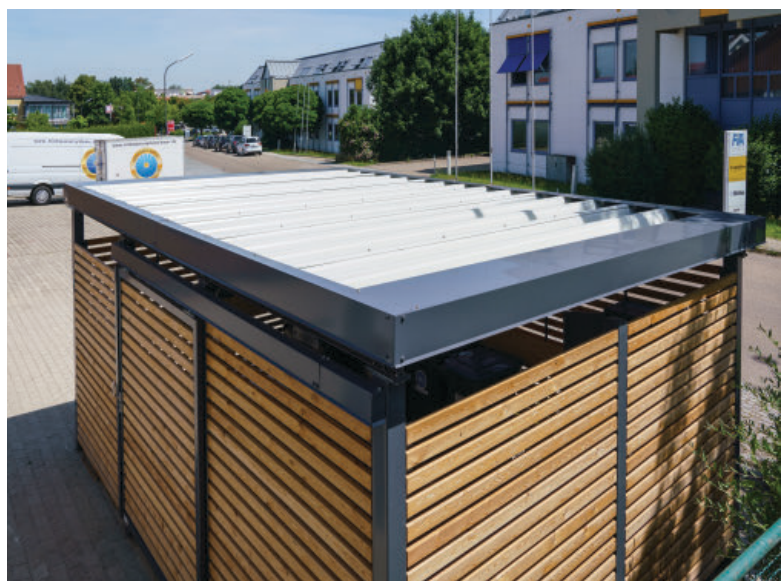
Müllhaus mit Trapezblechdach.
