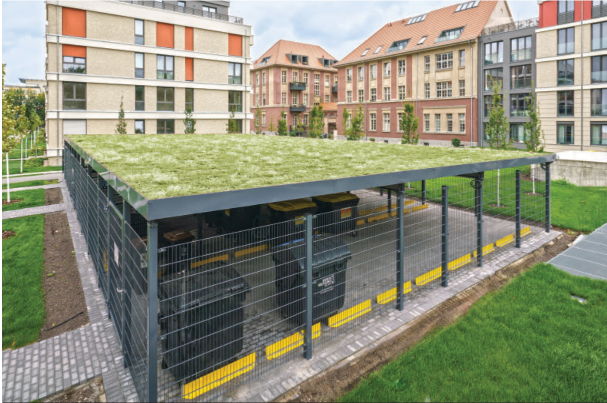
Mülleinhausung , Stützen nach RAL 7016 Anthrazitgrau pulverbeschichtet, Seitenverkleidung Gittermatten, Gründach Light.
