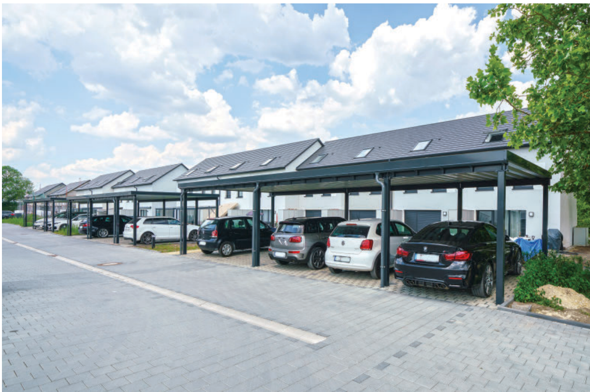
Carportanlage , Tragkonstruktion nach RAL 9016 Anthrazit pulverbeschichtet, , Trapezblechdacheindeckung.
