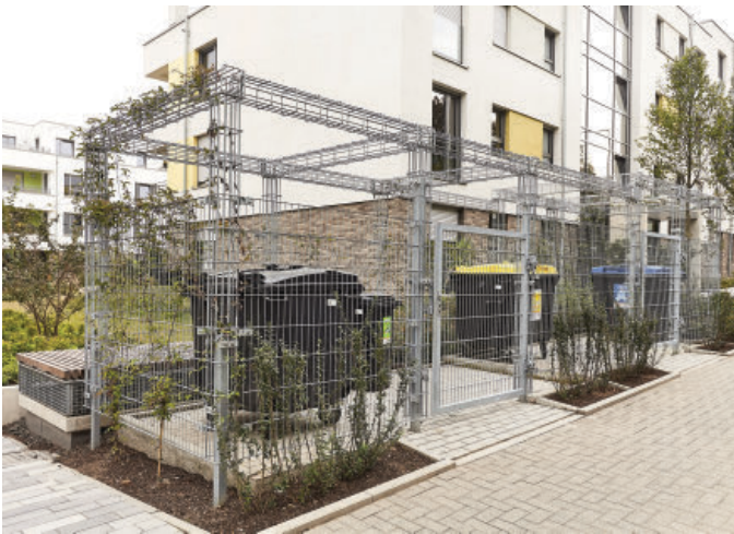
Müllplatz , Tragkonstruktion Drahtbalken.
