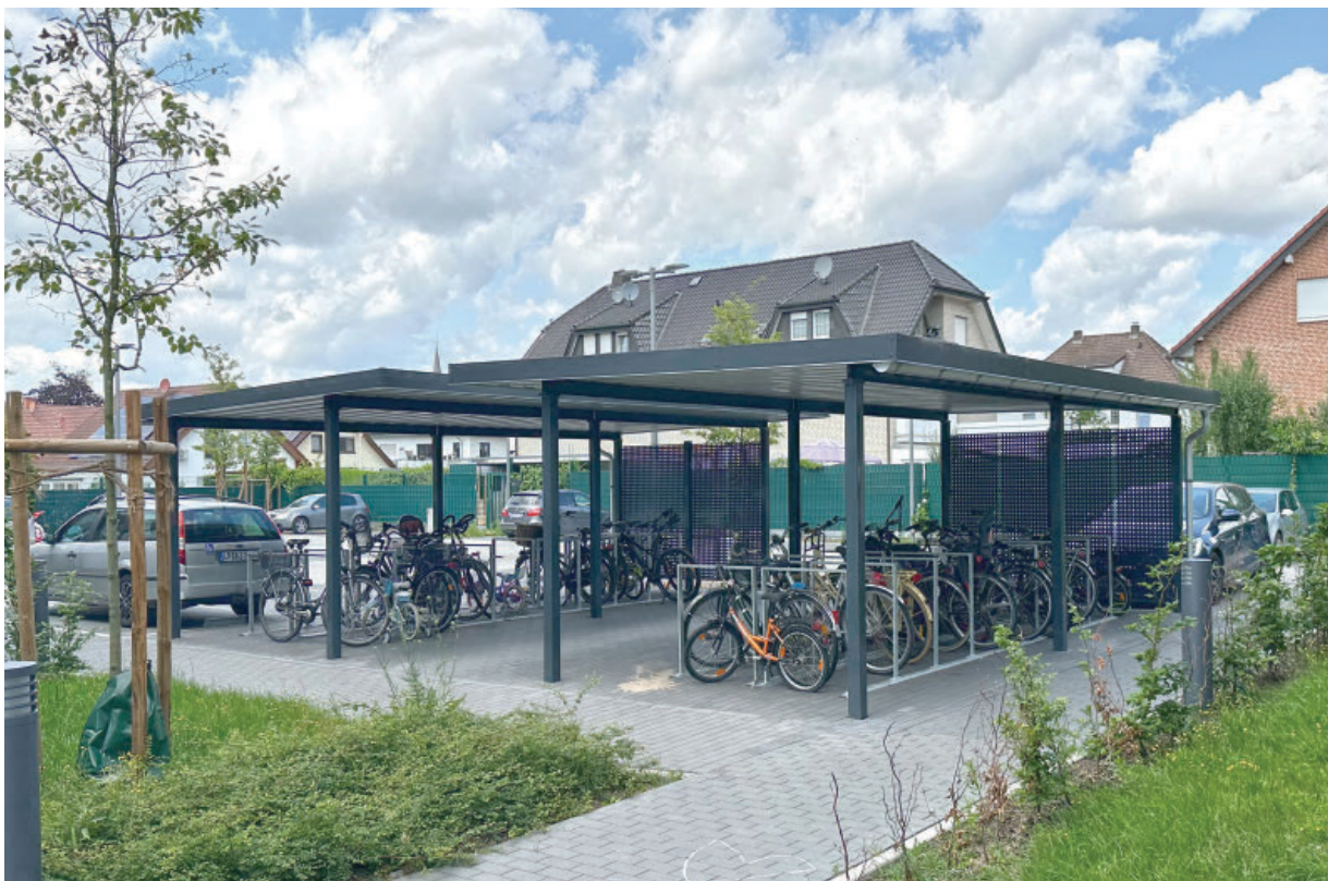
Fahrradeinhausung , Stützen und Seitenverkleidung Lochblech nach RAL 7016 Anthrazit pulverbeschichtet, Trapezblechdacheindeckung.
