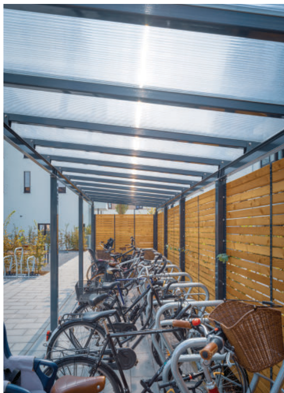
Fahrradüberdachung mit Stegdoppelplatten-Dach.
