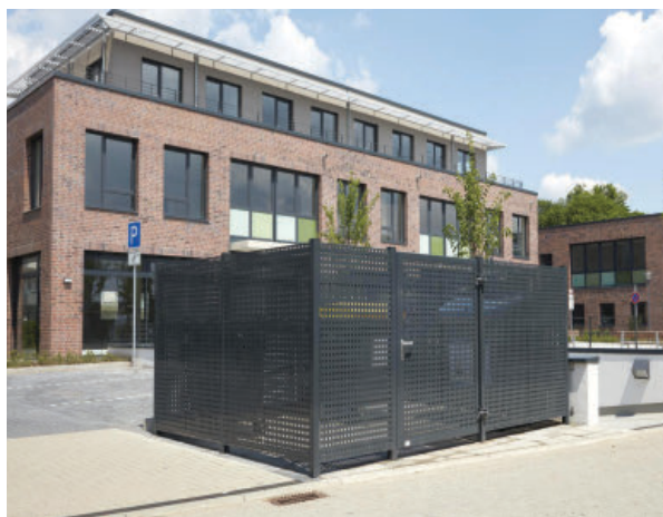
Müllplatz , Stützen und Seitenverkleidung Lochblech nach RAL 7016 Anthrazit pulverbeschichtet.
