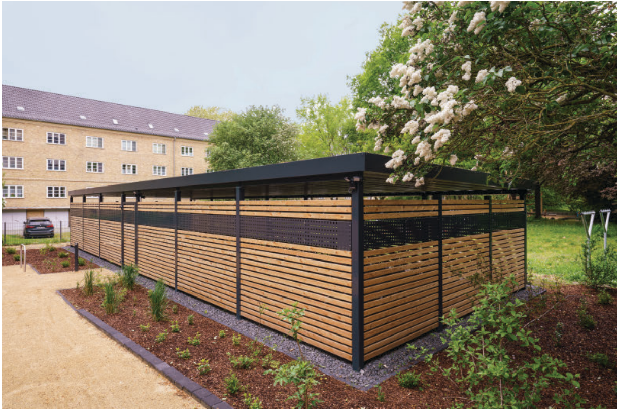
Fahrradeinhausung , Tragkonstruktion Anthrazitgrau pulverbeschichtet, Trapezblechdach, Seitenverkleidung Woodline Design.
