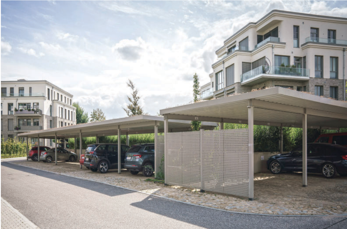
Carportanlagen und Müllhäuser , Stützen und Seitenverkleidung Lochblech nach RAL 7030 Steingrau pulverbeschichtet, Gründach Light.
