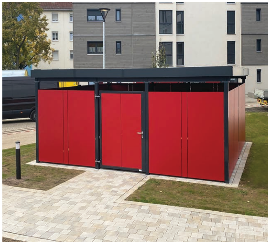
Mülleinhaus mit Seitenverkleidung TRESPA® METEON® UNI Carmine Red.
