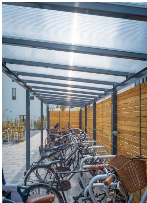
Fahrradüberdachung mit Polycarbonatdach.
