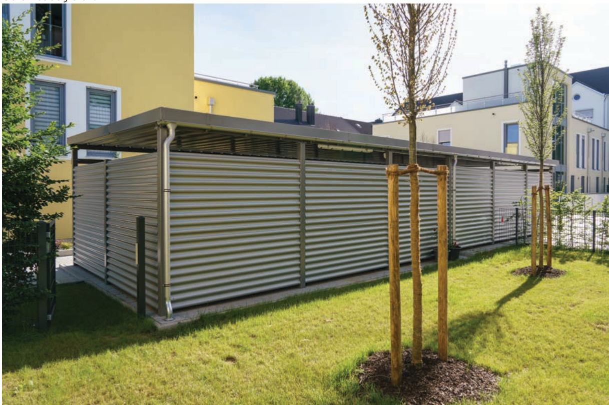
Müll- und Fahrradeinhausung , Tragkonstruktion nach RAL 9007 Graualuminium pulverbeschichtet, Seitenverkleidung Stahlwelle, Trapezblechdacheindeckung.
