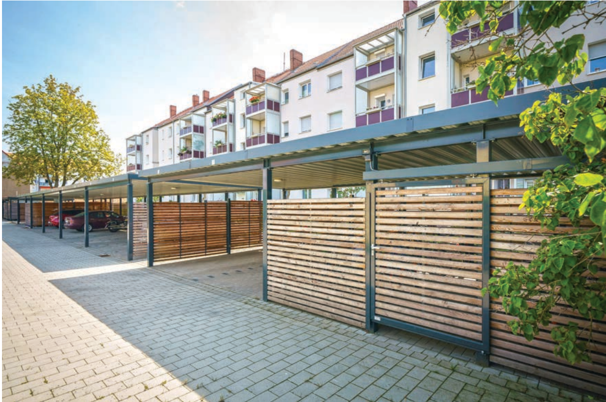
Carportanlage mit abschließbarem Abstellraum , Stützen nach RAL 7016 Anthrazit pulverbeschichtet, Seitenverkleidung Woodline, Hängeschiebetor und Gründach Light.
