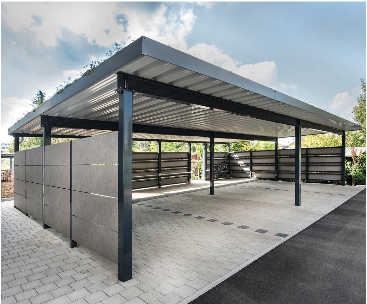
Reihencarport , Stützen nach RAL 7016 Anthrazit pulverbeschichtet, Seitenverkleidung Trespa Gründach Light.
