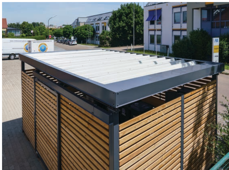
Müllhaus mit Trapezblechdach.
