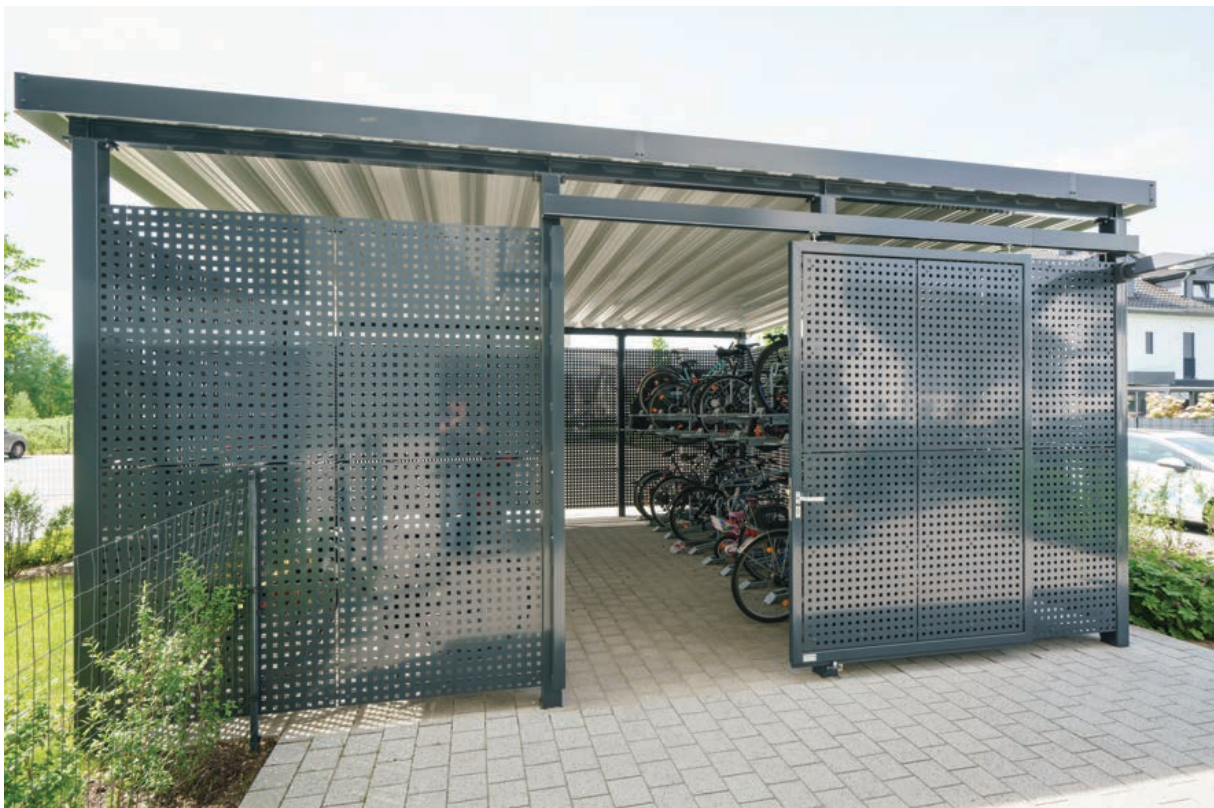
Fahrradeinhausung mit Doppelparker , Stützen und Seitenverkleidung aus Lochblech nach RAL 7016 Anthrazit pulverbeschichtet, Hängeschiebetor.
