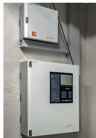
Optimal ausgestattet: Neben Gasthof und Hotel sind auch die Maschinenhalle, in der die Heizzentrale und der Hackschnitzelbunker untergebracht sind, an die Brandmeldezentrale von Telenot angeschlossen.
