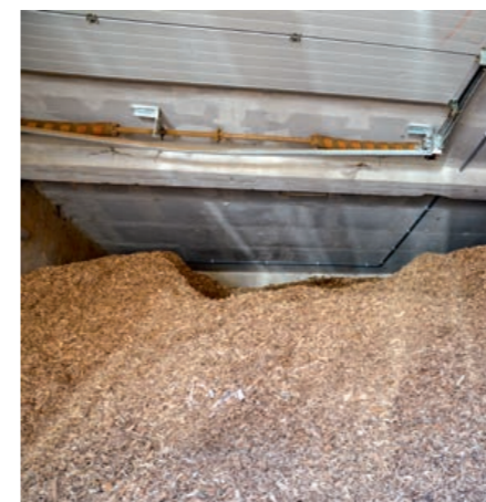
Über Rohrleitungen im Bunker, in dem die Hackschnitzel lagern, sowie im Heizraum wird ständig Umgebungsluft angesaugt. Erkennt die Rauchansauganlage (mittleres Bild) nur kleinste Rauchpartikel, wird ein Alarm ausgelöst.
