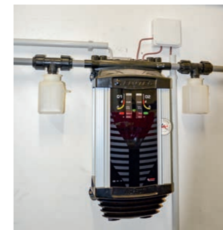
Über Rohrleitungen im Bunker, in dem die Hackschnitzel lagern, sowie im Heizraum wird ständig Umgebungsluft angesaugt. Erkennt die Rauchansauganlage (mittleres Bild) nur kleinste Rauchpartikel, wird ein Alarm ausgelöst.
