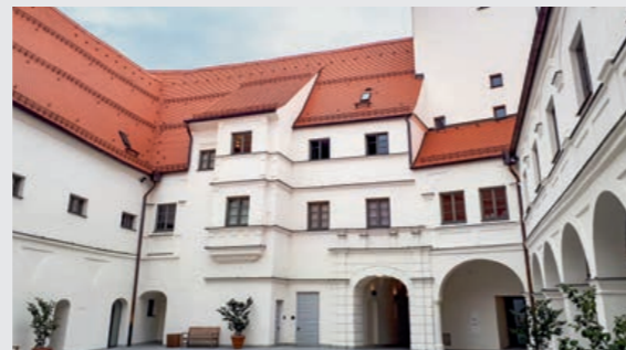
Herzstück der neuen Sicherheitslösung im Wittelsbacher Schloss in Friedberg sind zwei Telenot-Alarmanlagenzentralen vom Typ complex 400H.
