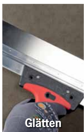
Verputzen von Kabelschlitzen
