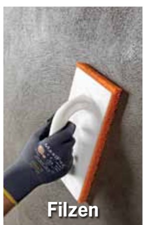
Verputzen von Kabelschlitzen
