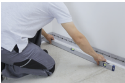
1. Prüfung des Untergrundes auf Eignung und Ebenföächigkeit.
