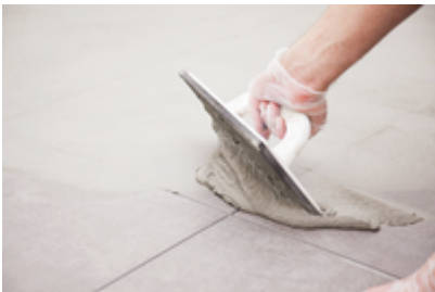
16. Die Belagsverfugung erfolgt nach Begehbarkeit der Belagsfläche.
