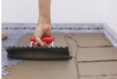
11. oder der Fliesenbelag wird „Frisch in Frisch“ mit Klebemörtel verlegt. Hierzu wird die ARDEX FLEXBONE® Zug um Zug ausgespachtelt und ...
