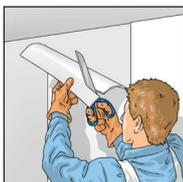
**6.** Überstände an Decken, Fußleisten, Fenstern usw. mit einer starken Schere oder mit einem Hakenklingmesser und dem Spachtel abtrennen.
