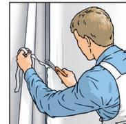
**5.** In Ecken und an Kanten Tapetenbahn abtrennen und nachfolgende Bahn auf Stoß tapezieren.
