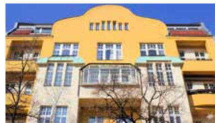
Gebäude mit fehlendem Dachvorsprung
