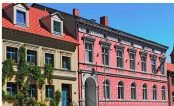
Gebäude mit Grenzbebauung
