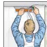
**5.** Überstände an Decken, Fußleisten, Fenstern usw. mit dem Cuttermesser und dem Tapezierspachtel beschneiden.
