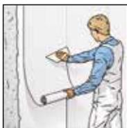
**3.** Den Wandbelag in Wandklebetechnik mit der dunklen Unterseite in den ERFURT-Systemkleber auf Stoß einlegen. Mit einem Kunststoffspachtel andrücken. Eine horizontale Verklebung der Bahnen ist ebenfalls möglich.
