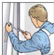
**4.** In Ecken und an Kanten wird nicht überlappend tapeziert, sondern die Trennung erfolgt exakt auf der Kante und nachfolgende Bahn auf Stoß tapezieren.
