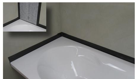
**9** Nach dem Anbringen des DISK Wannendichtbandes und der DISK CORN-WB folgt die Verklebung des DISK TAPES im aufsteigenden Eckbereich. Anschließend erfolgt die Flächenabdichtung mit Blanke DISK. Die Verlegeanleitung von Disk ist zu beachten.
