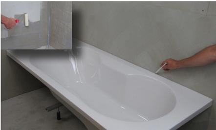
**1** Die Höhe der ausgerichteten Bade- oder Duschwanne anzeichnen, diese von der Wand abrücken und die Wände grundieren.
