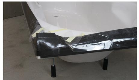
**6** Die Schutzfolie von DISK CORN-WB entfernen und die Schutzfolie des DISK Wannendichtbandes nahe der Ecke auf dem Wannenträger mit Kreppband fixieren.
