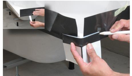
**3** Das DISK Wannendichtband 1 cm von der Wannenträgerdecke beginnend, an der Unterkante bündig aufkleben. Das Formstück Blanke DISK CORN-WB auf dem DISK Wannendichtband anzeichnen. Die Schutzfolie von dem DISK Wannendichtband ein Stück lösen und mit Kreppband fixieren.
