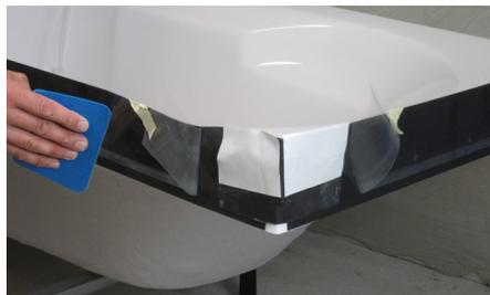
**5** Das Wannendichtband sowie die Formstücke mit dem Disk-Tool gleichmäßig faltenfrei andrücken.
