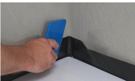
**7** Die Wanne am Standort positionieren, die Fixierung (Kreppband) lösen, DISK CORN-WB an die Wandecke fügen und mit dem DISK-TOOL andrücken.
