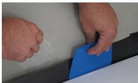
**8** Im Anschluss die Schutzfolie des DISK Wannendichtbandes nach und nach abziehen und gleichzeitig das Wannendichtband mit dem DISK-TOOL an die Wand andrücken.
