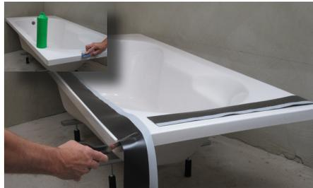
**2** Die Wannenträger reinigen und entfetten. Das DISK Wannendichtband auf die Wannenschenkelmaße minus 1 cm ablängen.
