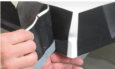
**4** Das Butylschutzband auf dem Formstück Blanke DISK CORN-WB entfernen. DISK CORN-WB an der Markierung (auf dem DISK Wannendichtband) so ansetzen, dass die Oberkante des Butylstreifen auf der Unterkante der Klebefläche des Wannendichtbandes aufliegt.
