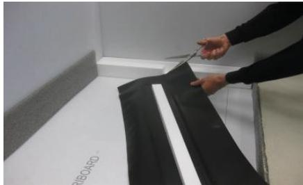
**2** Abdichtungsflansch in den entsprechenden Ecken zuschneiden und nach Aushärtung des Fliesenklebers Edelstahlkörper in den Installationsblock einsetzen.
