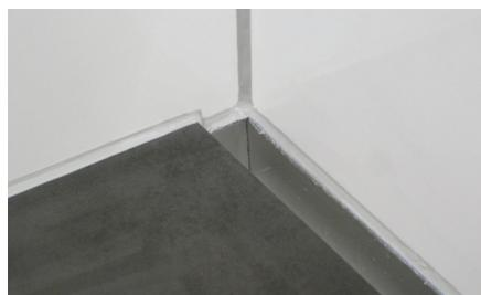
**8** Schutzkern entfernen und die Anschlussfugen zwischen Edelstahlkörper und Wandbekleidung dauerelastisch mit neutralvernetztem Silikon versiegeln.
