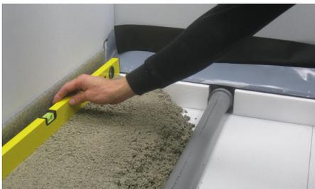
**4** Zu allen aufsteigenden Bauteilen ist ein Randdämmstreifen zu setzen. Fachgerechten Estrich einbringen und die Oberfläche bündig mit dem Installationsblock abziehen. Die breite Seite des Installationsblocks ist als Abziehlehre zu verwenden. Ein Gefälle von 2% ist einzuhalten.
