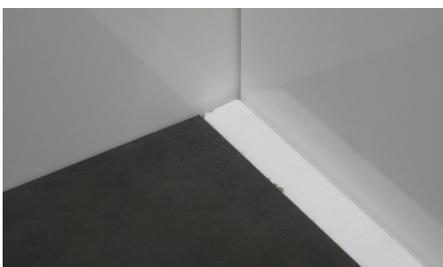
**7** Der Fliesenbelag ist nach den derzeit gültigen Normen und Regeln im Dünnbettverfahren zu erstellen. Zweite Entwässerungsebene zwischen Bodenbelag und Abdichtungsflansch im Rinnenbereich hohlraumfrei, zementär ausführen. Zur Gestaltung der Übergänge an Wand und Boden stehen unsere BLANKE AQUA-PROFILE zur Verfügung.
