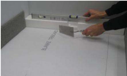
**1** Einbauhöhe bestimmen, Einbauposition säubern, Installationsblock mittels Fliesenkleber direkt am Untergrund ansetzen und in Waage ausrichten. Rohrmuffe bei der Einbauhöhe berücksichtigen und ggf. einstemmen.
