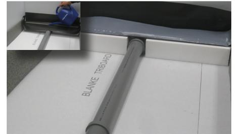
**3** BLANKE DISK-LINE EC mit einem Gefälle von 2% an die Hausentwässerung anschließen und auf Dichtheit überprüfen. Schutzkern im Anschluss in die Linienentwässerung einsetzen.
