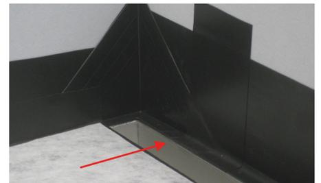
**6** Eine zusätzliche Verklebung am Ende der Formteile (Pfeil) mittels DISK TAPE zum Rinnenkörper rechts und links ist erforderlich. DISK TAPE auf ca. 10 x 10 cm zuschneiden und auf den 1,5 cm breiten Rinnenkörper aufkleben. Im Anschluss das DISK TAPE mit 5 cm Überlappung über das Formteilende senkrecht ankleben. Verbundabdichtung komplett erstellen.
