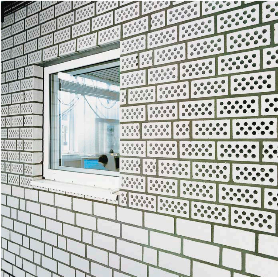
Bild 44: Schallschluckwand aus KS-Schallschlucksteinen (Lochsteine, werkseitig durchstoßen)
