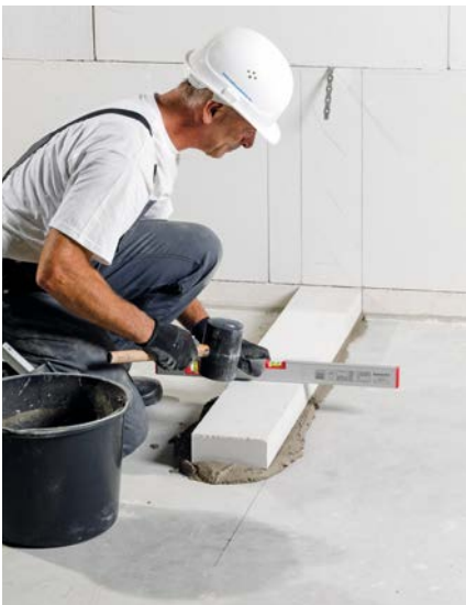
Bild 35 Kimmsteine in Querrichtung ausrichten
