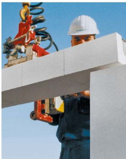
Bild 27 Vorgefertigte KS-Flachstürze zur schnellen und rationellen Öffnungsüberdeckung
