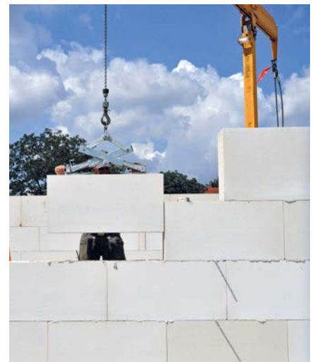
Bild 24 Vermauern von KS XL-Plan-elementen
