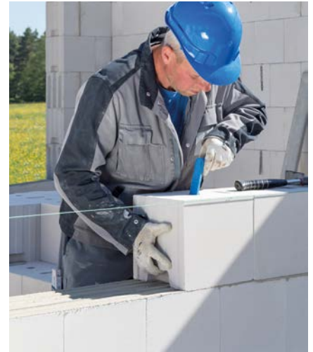
Bild 21 KS -R-Plansteine für Dünnbettmörtel
