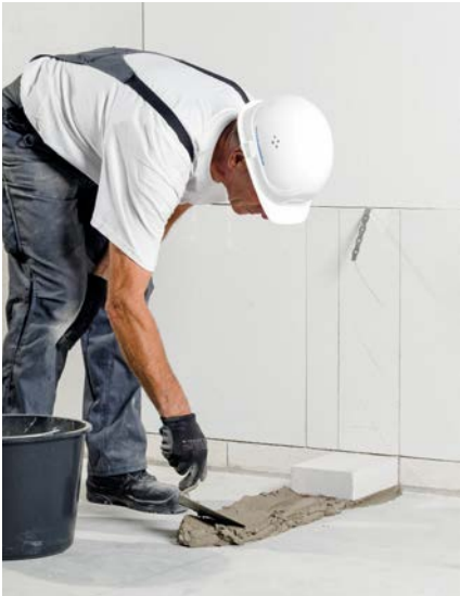
Bild 33 Mörtel auf die Betonsohle auftragen
