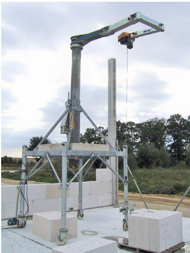
Bild 32 Versetzgerät
