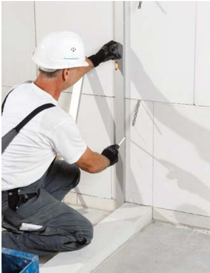
Bild 37 Anreißen der zu erstellenden Wand
