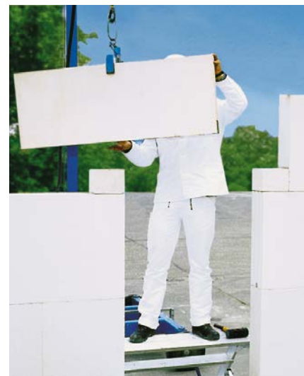
Bild 28 KS-Fertigteilstürze für großformatiges Mauerwerk
