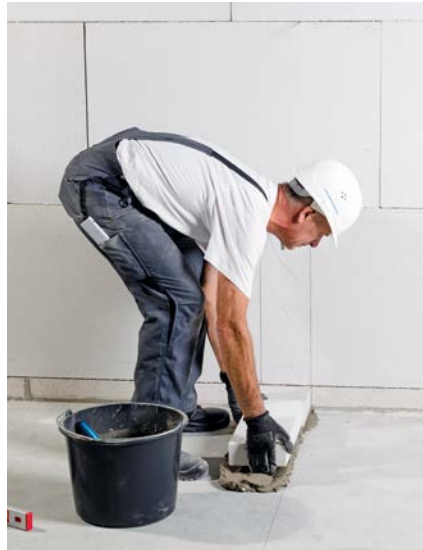
Bild 34 Kimmsteine ins Mörtelbett verlegen
