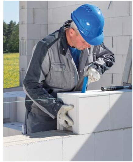
Bild 4 Versetzen von KS -R-Plansteinen in Dünnbettmörtel
