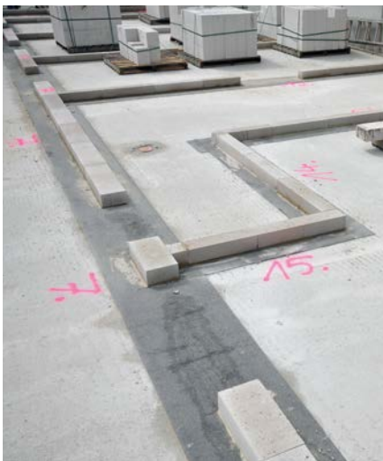
Bild 22 Anlegen der Kimmerschicht
