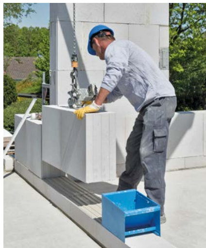
Bild 23 Vermauern von KS XL-Raster-elementen
