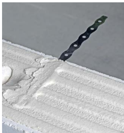
Bild 35 Stumpfstoßtechnik: Mörtelbett mit Edelstahl-Flachanker
