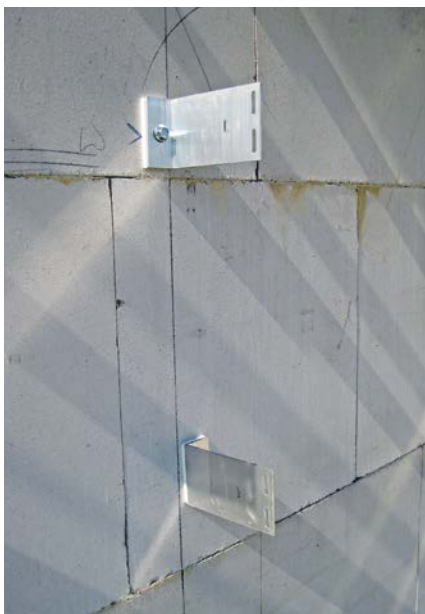
Bild 36 Aluminium-Unterkonstruktion mit Wandhaltern
