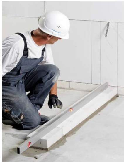
Bild 36 Kimmsteine in Längsrichtung ausrichten
