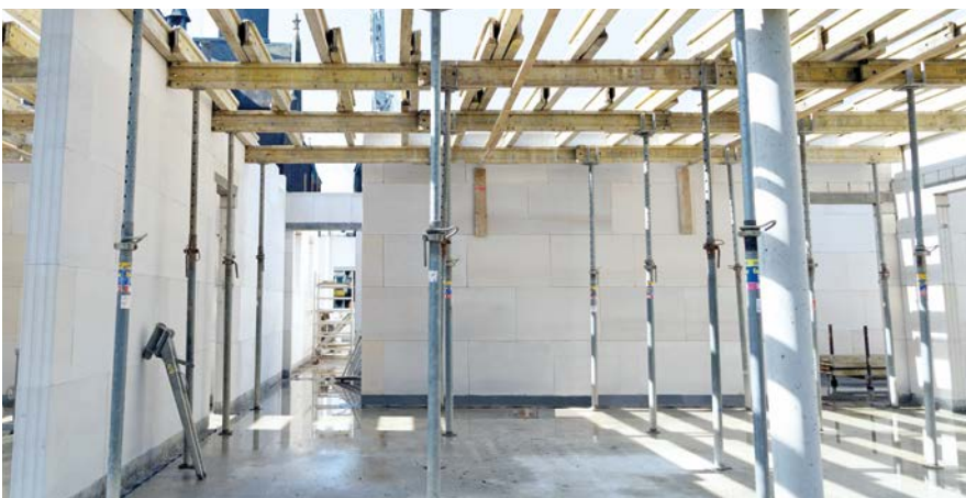
Bild 35 Kimmsteine in Querrichtung ausrichten
