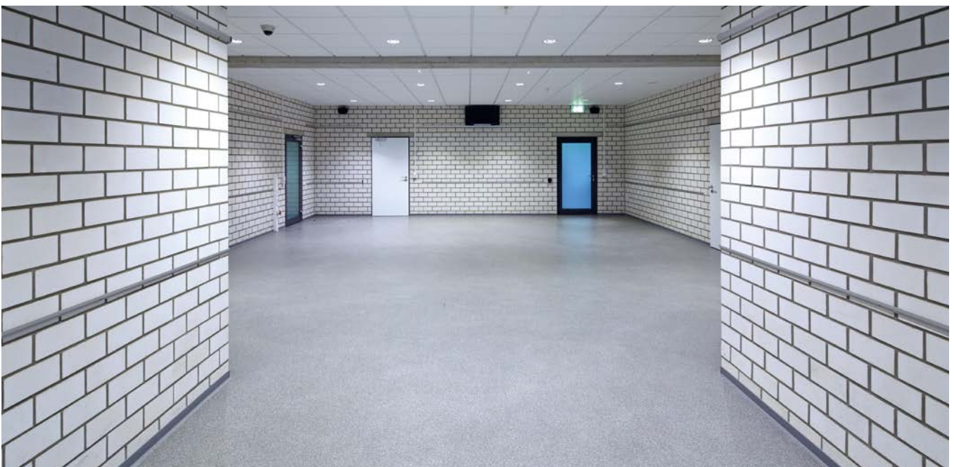
Bild 21 Halbstein-Überbindung minimiert Rissrisiko
